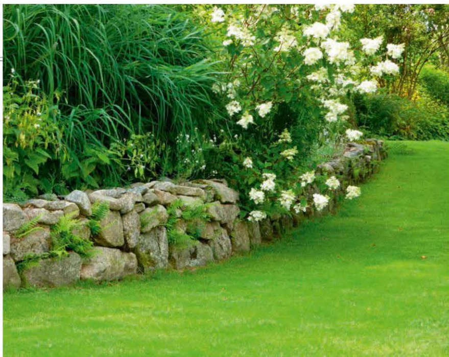
Ce petit muret de soutènement en pierres sèches a permis d'intégrer l'allée dans la déclivité générale du terrain, d'en travailler le profil longitudinal et la pente transversale pour lui donner une certaine esthétique et un confort de marche. Une végétation indigène s'installe tout naturellement entre les pierres du muret. (Jardin de Berchigranges)
