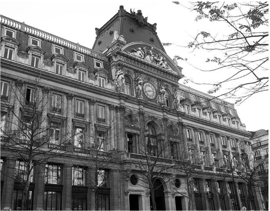
Le siège du Crédit Lyonnais est un bel exemple de l'architecture commerciale parisienne de la fin du XIX e siècle.
