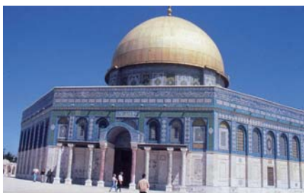
Figure 11.1. Mosquée du Rocher à Jérusalem.
