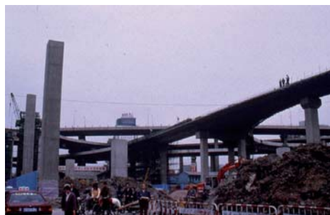
Figure 16.23. Le même emplacement en 1997.
