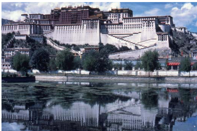
Figure 13.3. Le Potala, vue du centre de Lhasa.
