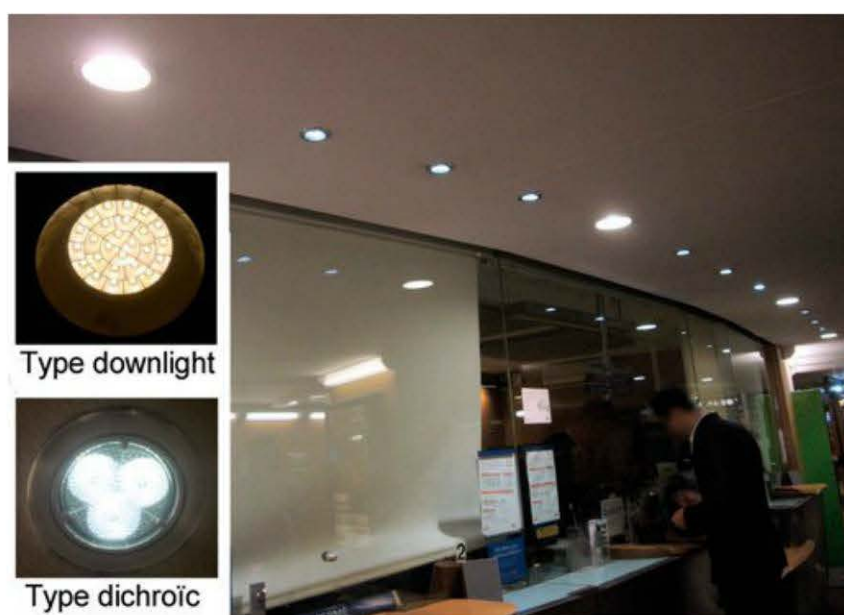
Figure 10.20 – Éclairage de type down light (encastré de plafond – métro parisien).
