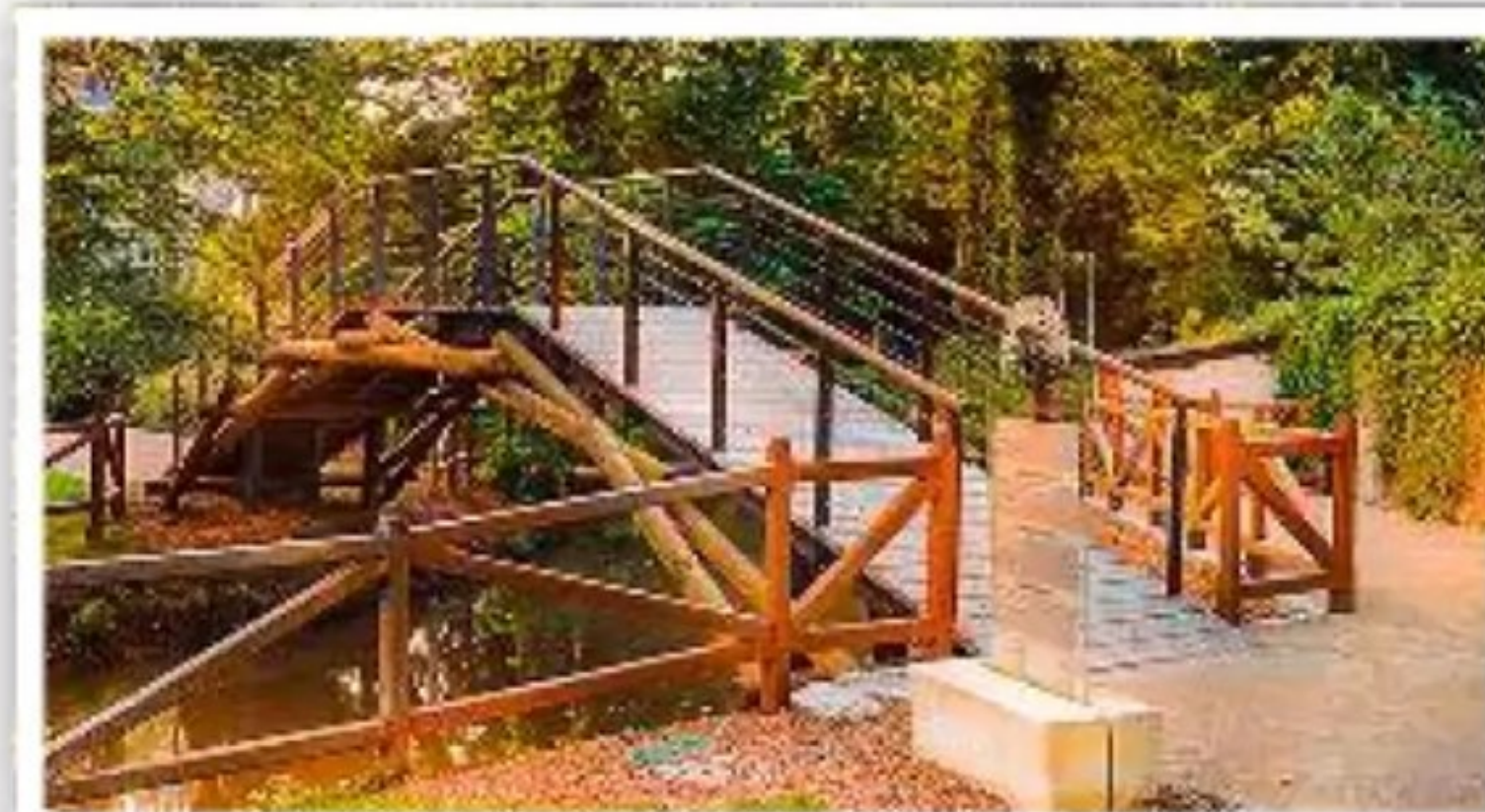
➤ Le pont autoportant (E)
