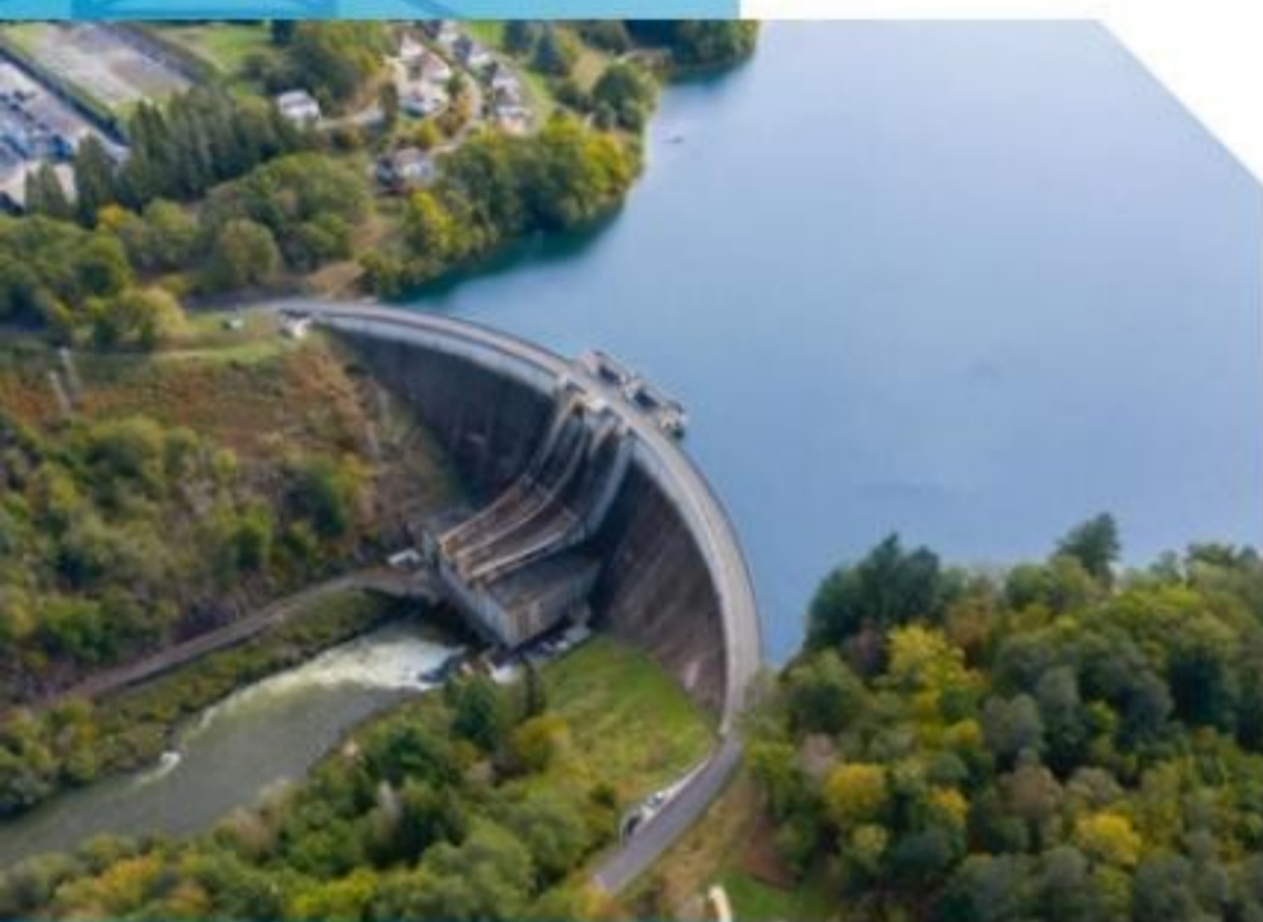
Le barrage hydroélectrique de Saint-Étienne-Cantalès (Cantal).
