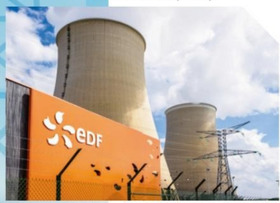
La centrale nucléaire de Nogent-sur-Seine (Aube).
