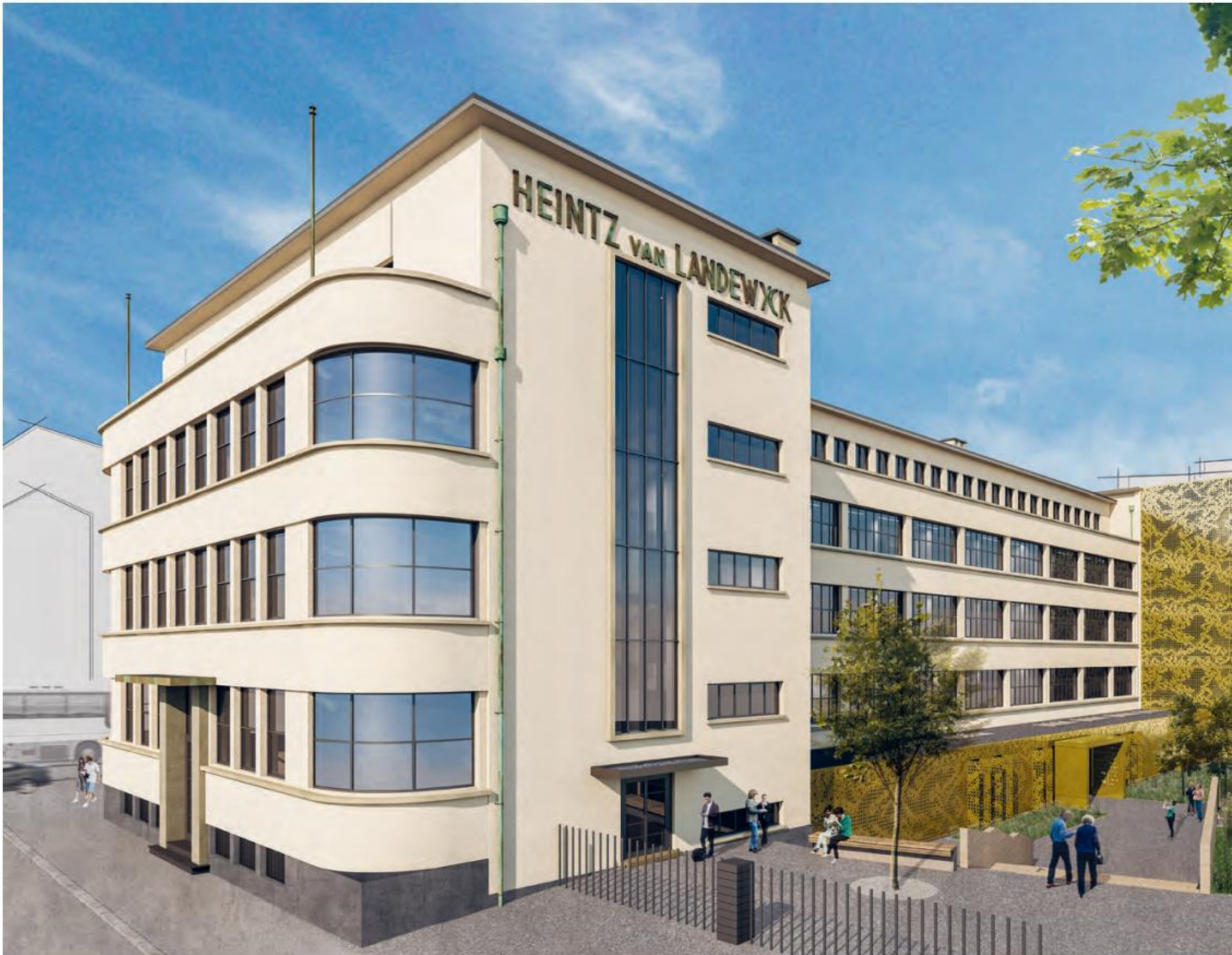
Le bâtiment historique datant des années 1930 est restauré et adapté pour accueillir des bureaux.
