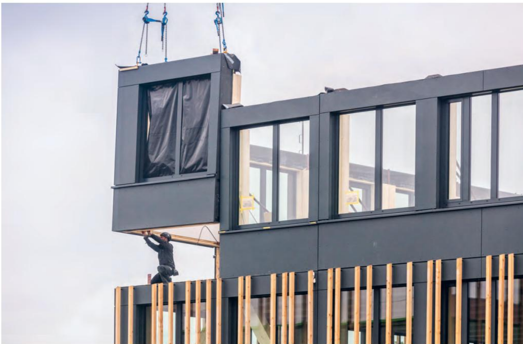
Les modules préfabriqués sont acheminés par grue jusqu'à leur emplacement de montage.
