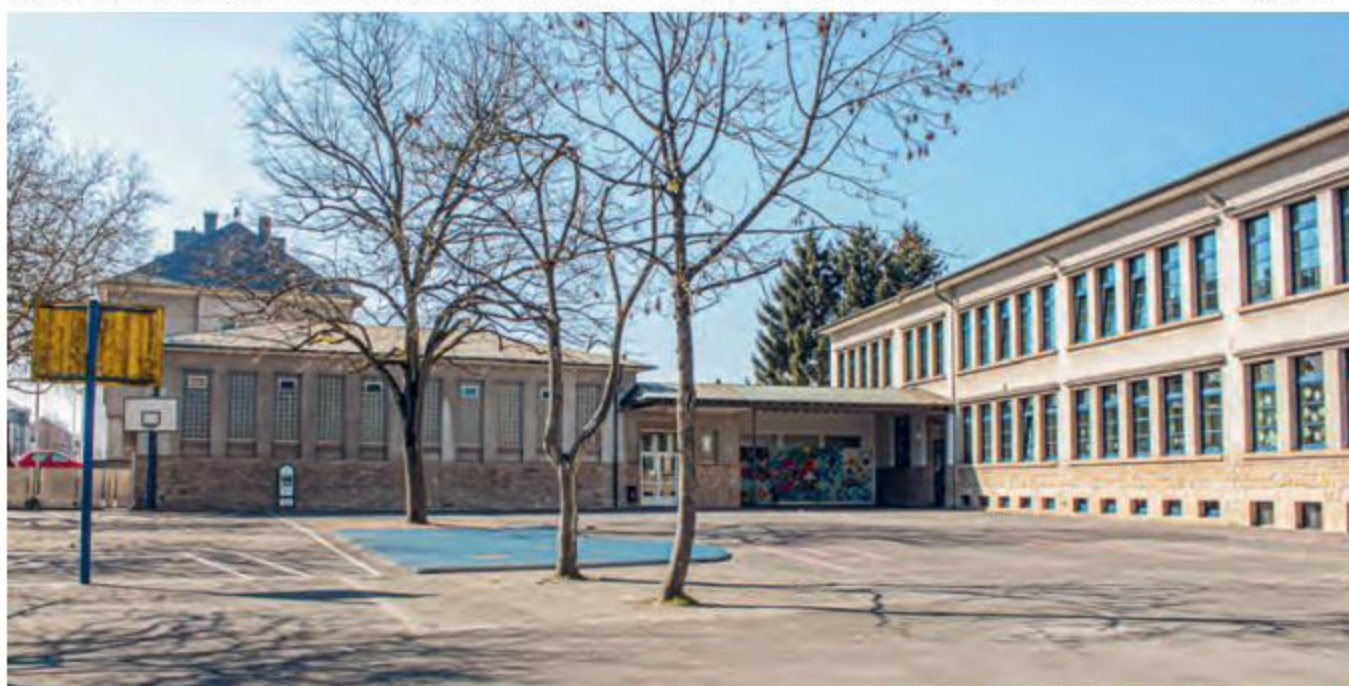
Vue de l'existant avant les travaux.
