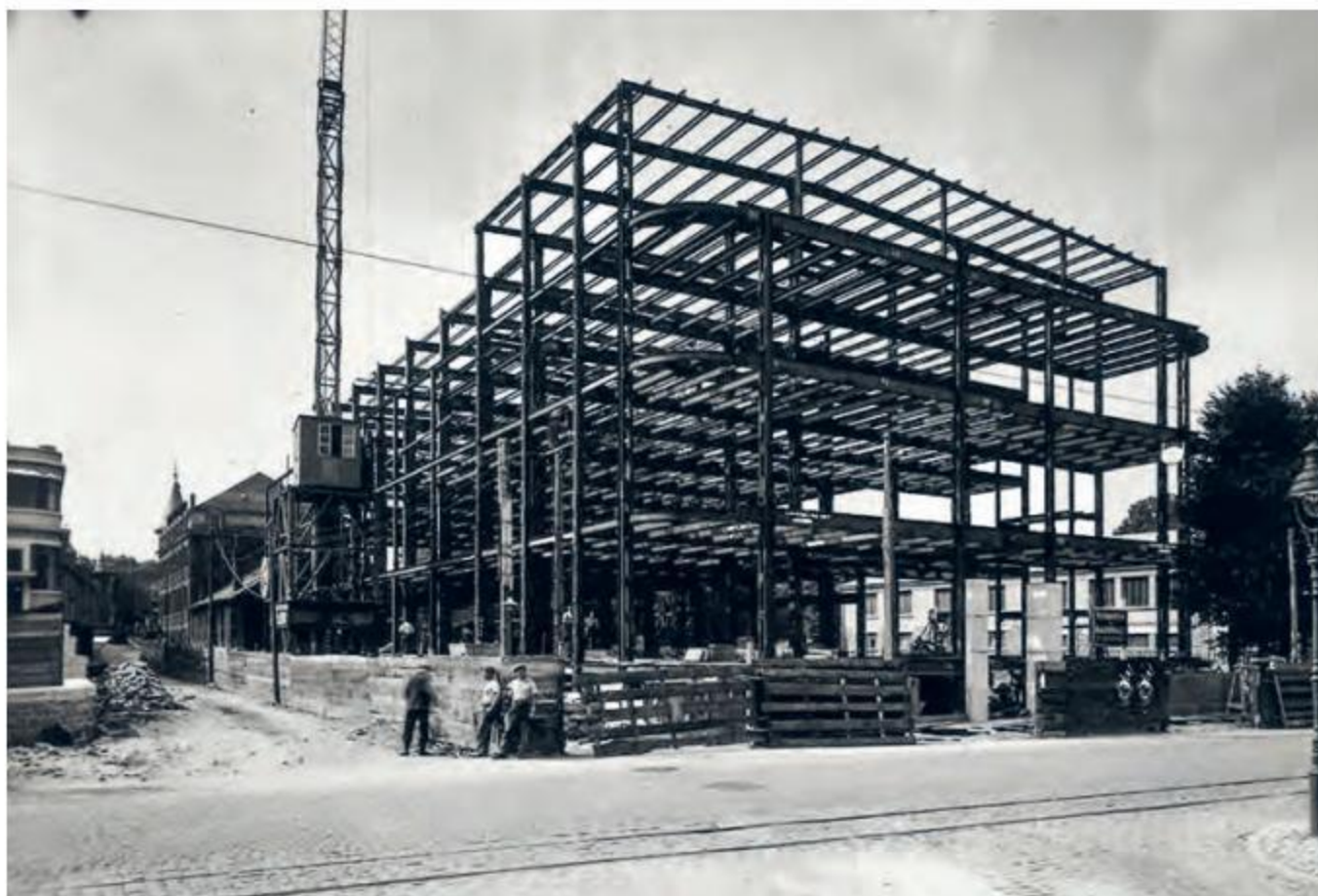
Sur cette photo historique, on voit la structure métallique qui sert de squelette au bâtiment.
