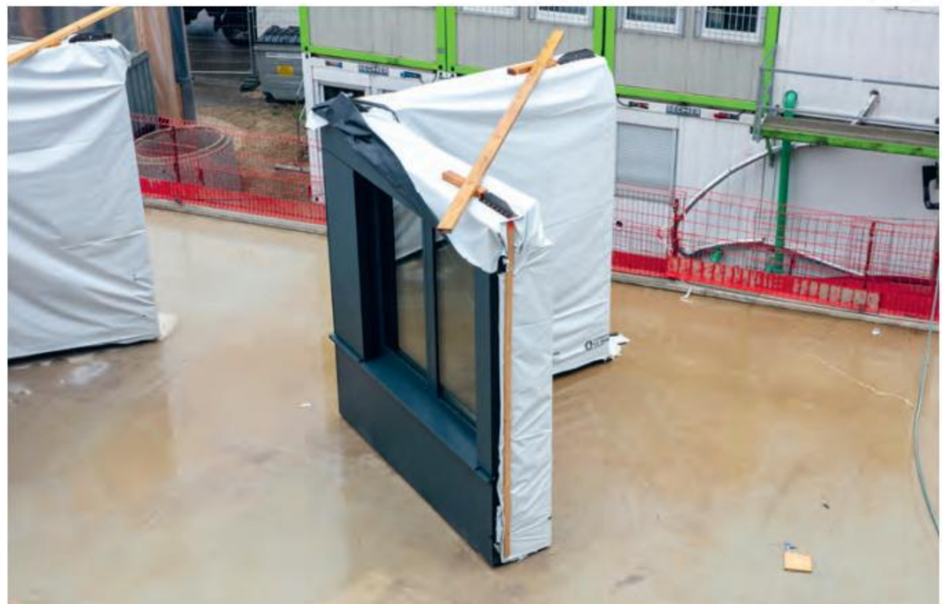
Les modules des façades comprennent le revêtement extérieur, l'isolation et même la fenêtre.
