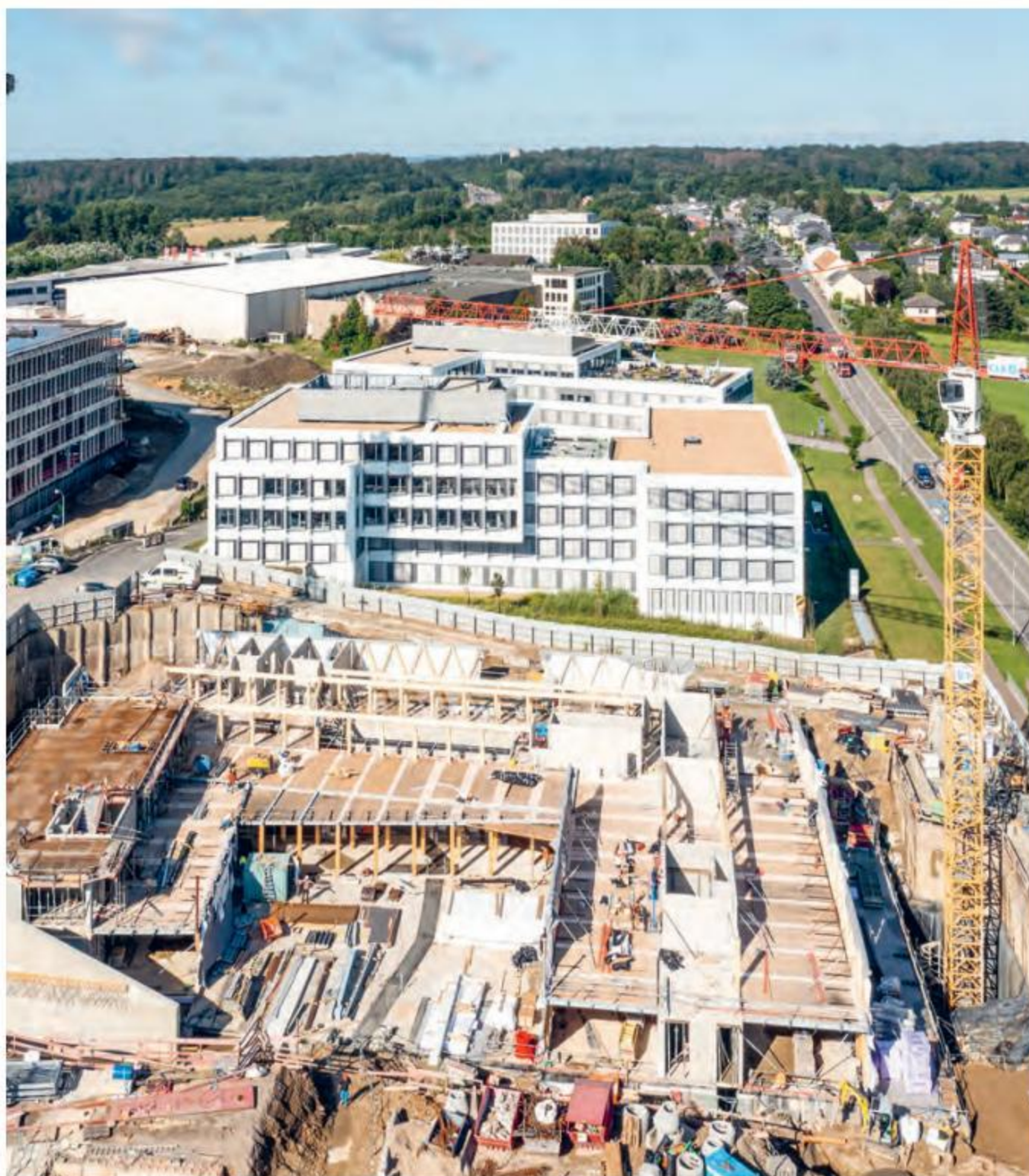
Grâce à la rapidité d'exécution de la construction en bois, un étage peut être monté en 10 jours.
