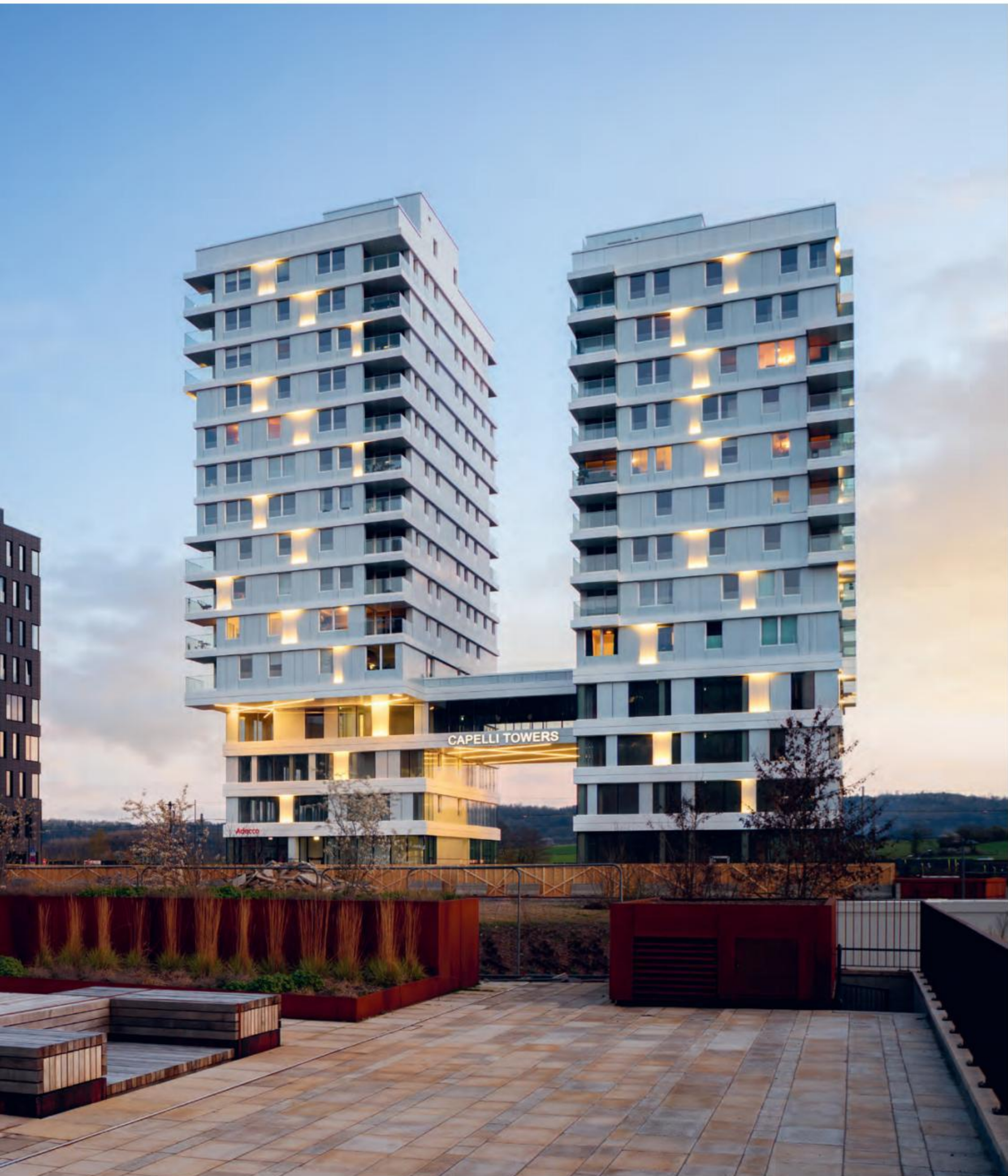
Les Capelli Towers marquent l'environnement urbain de Belval, encore en construction.
