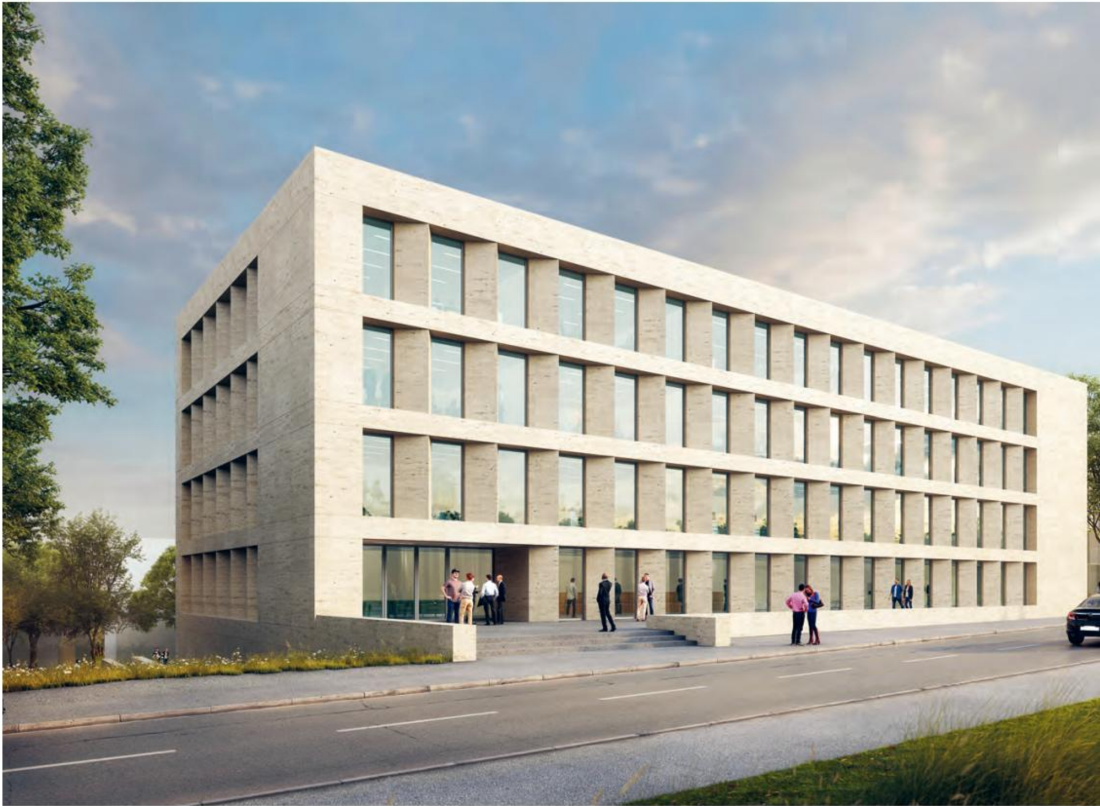
Côté rue, le bâtiment présente une trame régulière qui scande les quatre niveaux.
