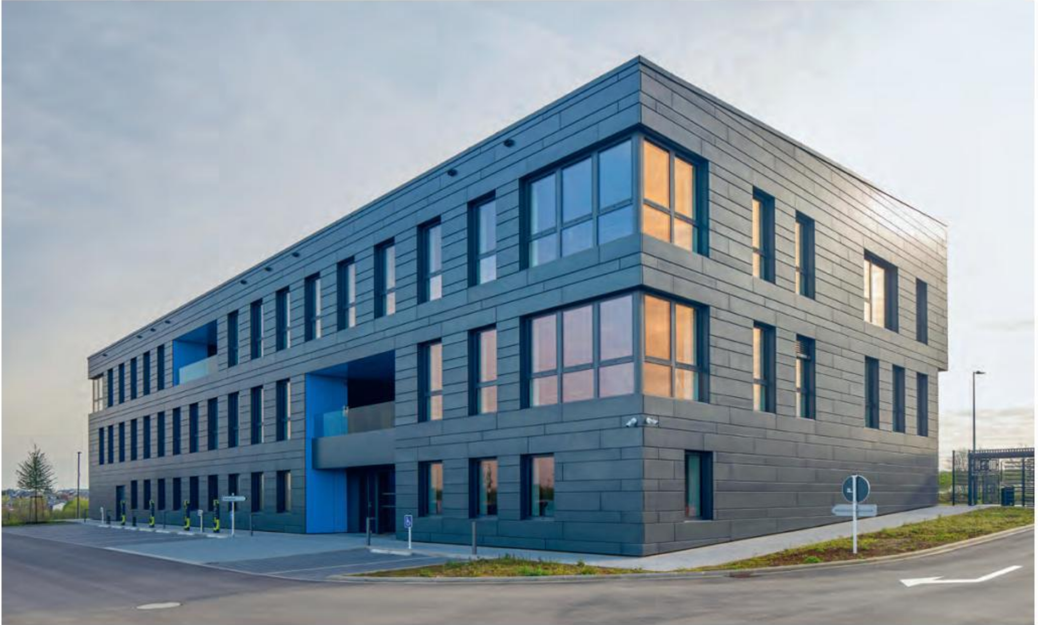
L'entrée du bâtiment est signalée par un volume évidé aux parois bleues qui contrastent avec le reste de la façade.
