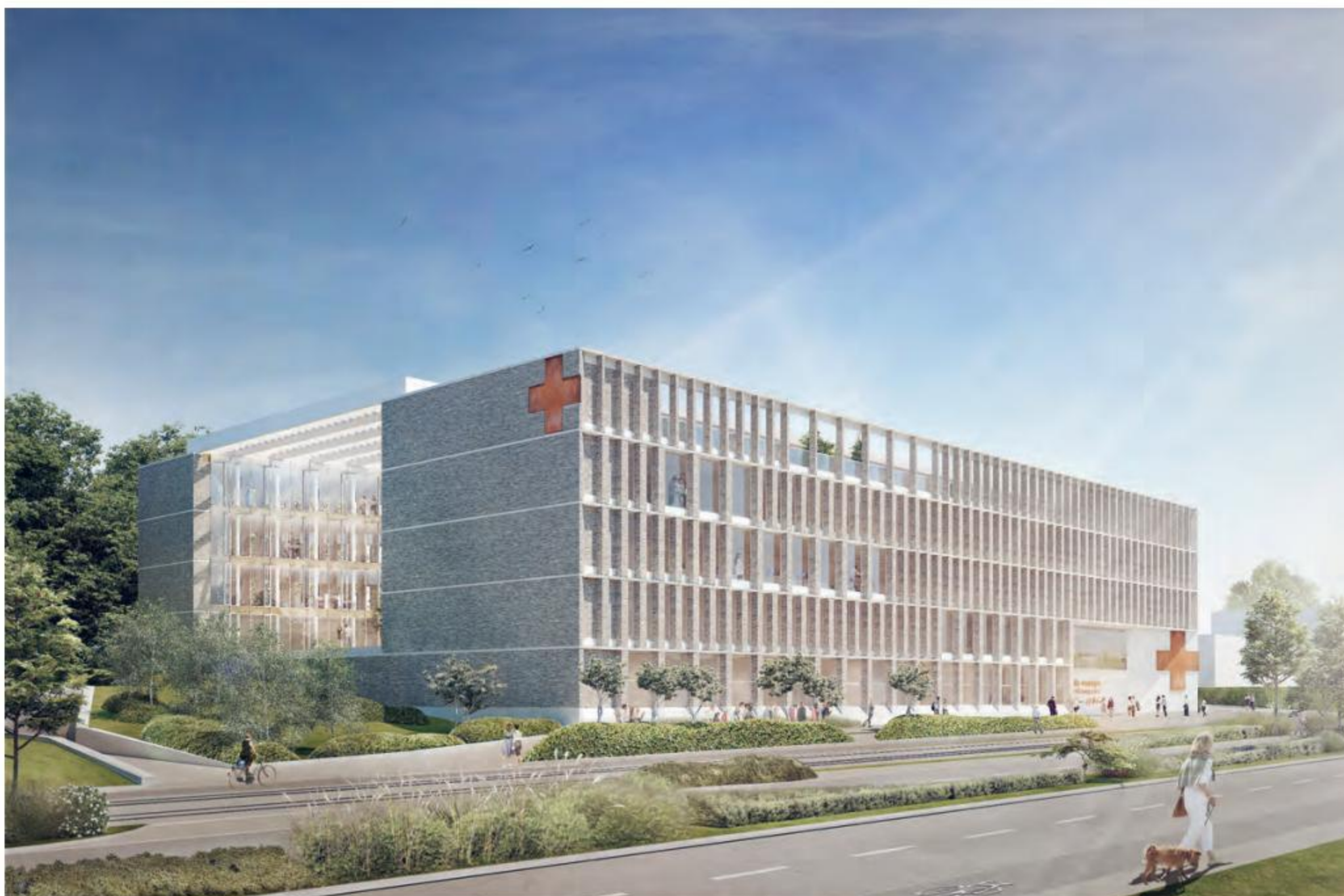
Entre les deux ailes du bâtiment, un patio intérieur apportera sérénité et lumière naturelle.
