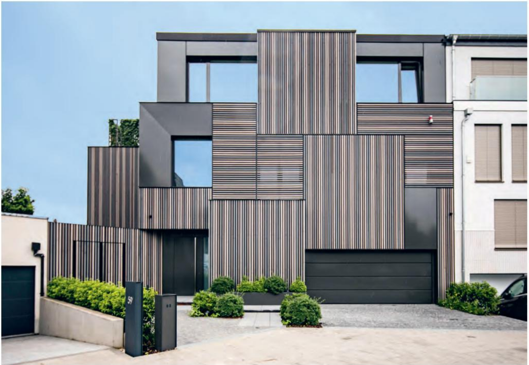
Depuis la rue, l'agencement des tubes en terre cuite, en façade, donne un caractère dynamique à la maison.
