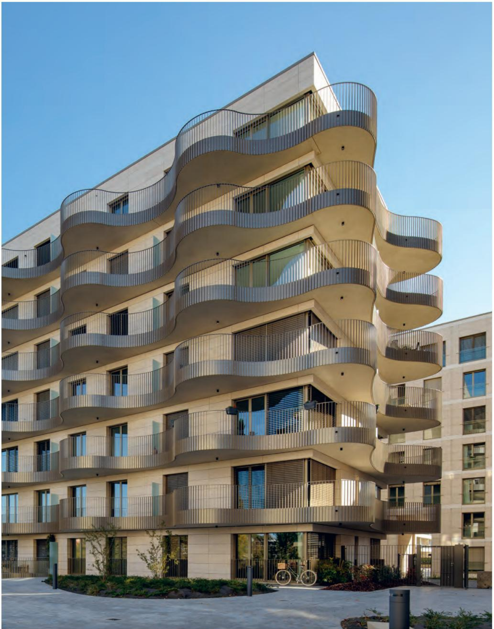
La ligne des balcons est pensée comme une courbe filant sur toute la façade.
