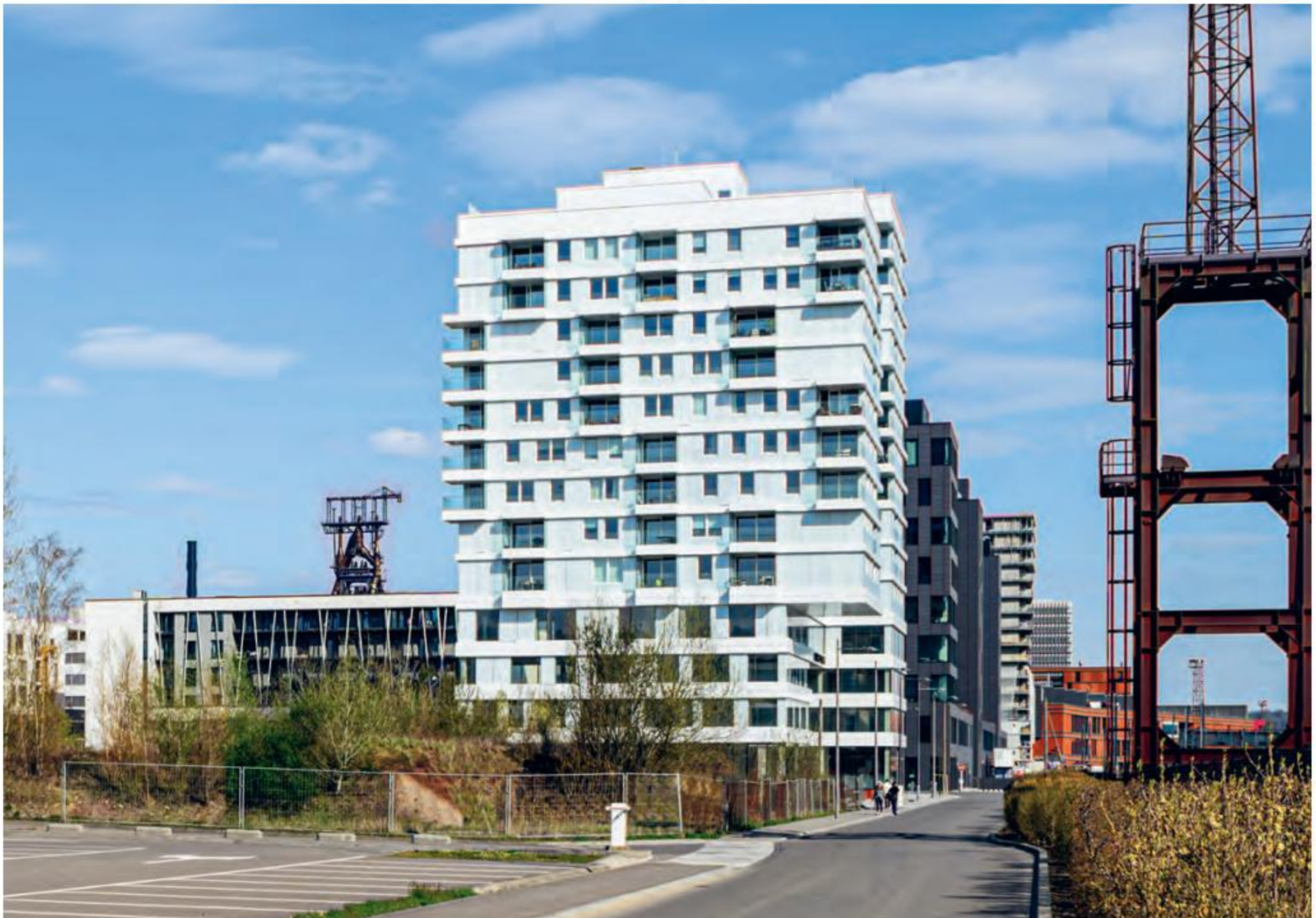
Les façades réalisées en verre émaillé blanc tranchent dans le paysage.
