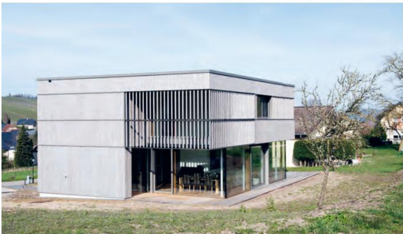
Cette maison en bois repose sur un socle en béton.
