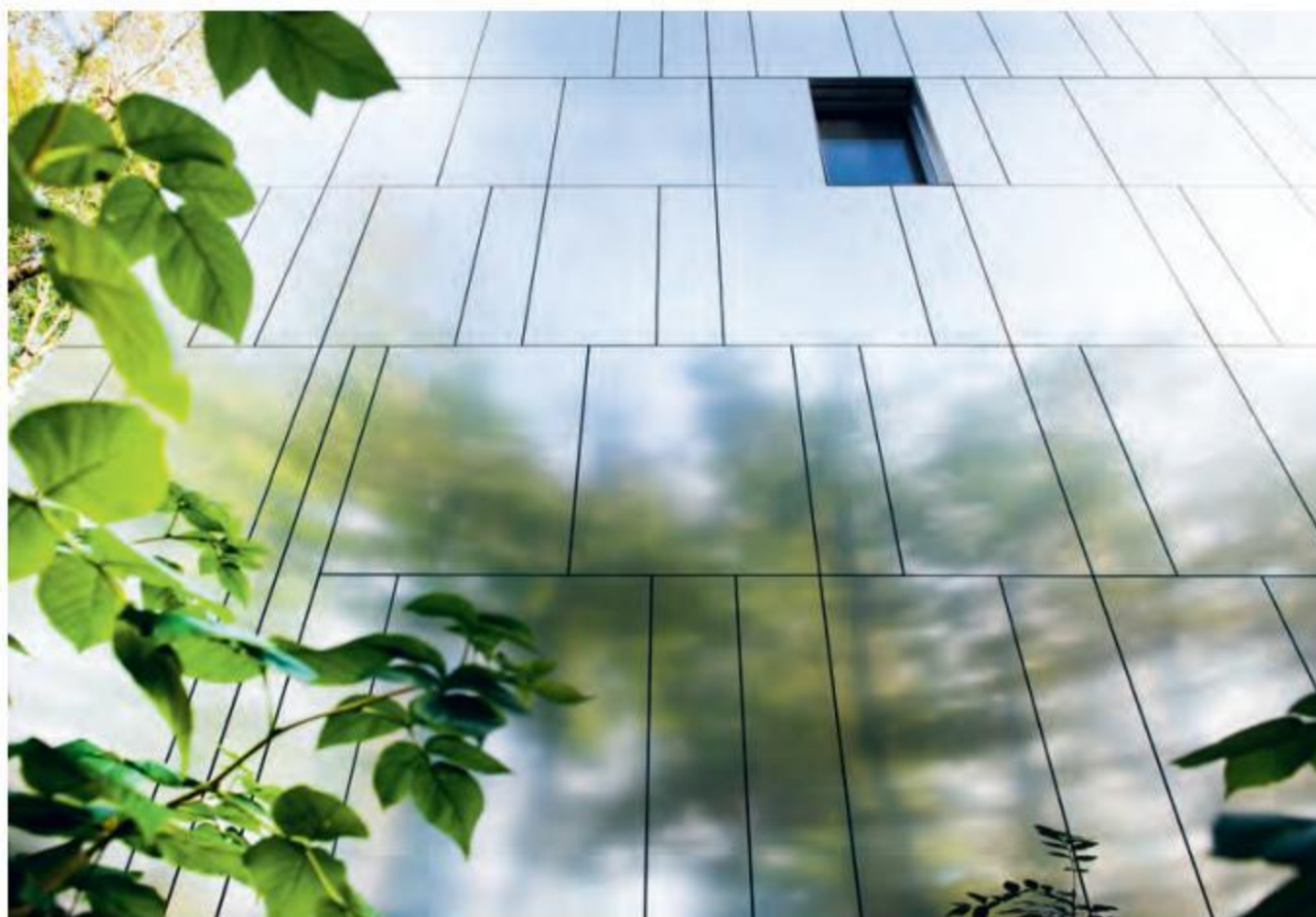
Le revêtement de façade est en tôle d'aluminium, avec un aspect miroir mat.
