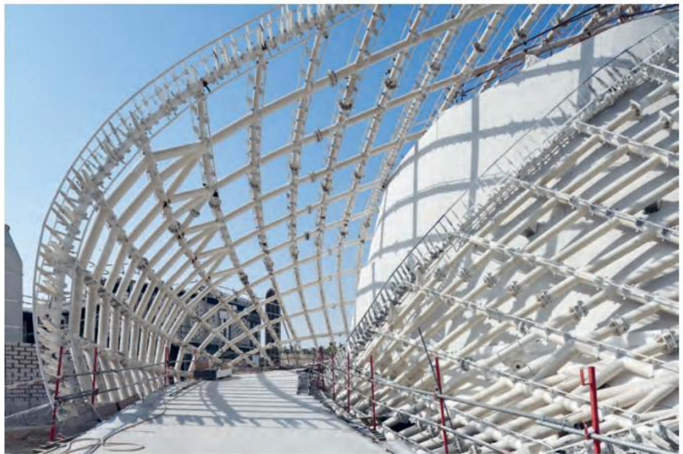
Le pavillon est réalisé à partir d'une vaste structure métallique.
