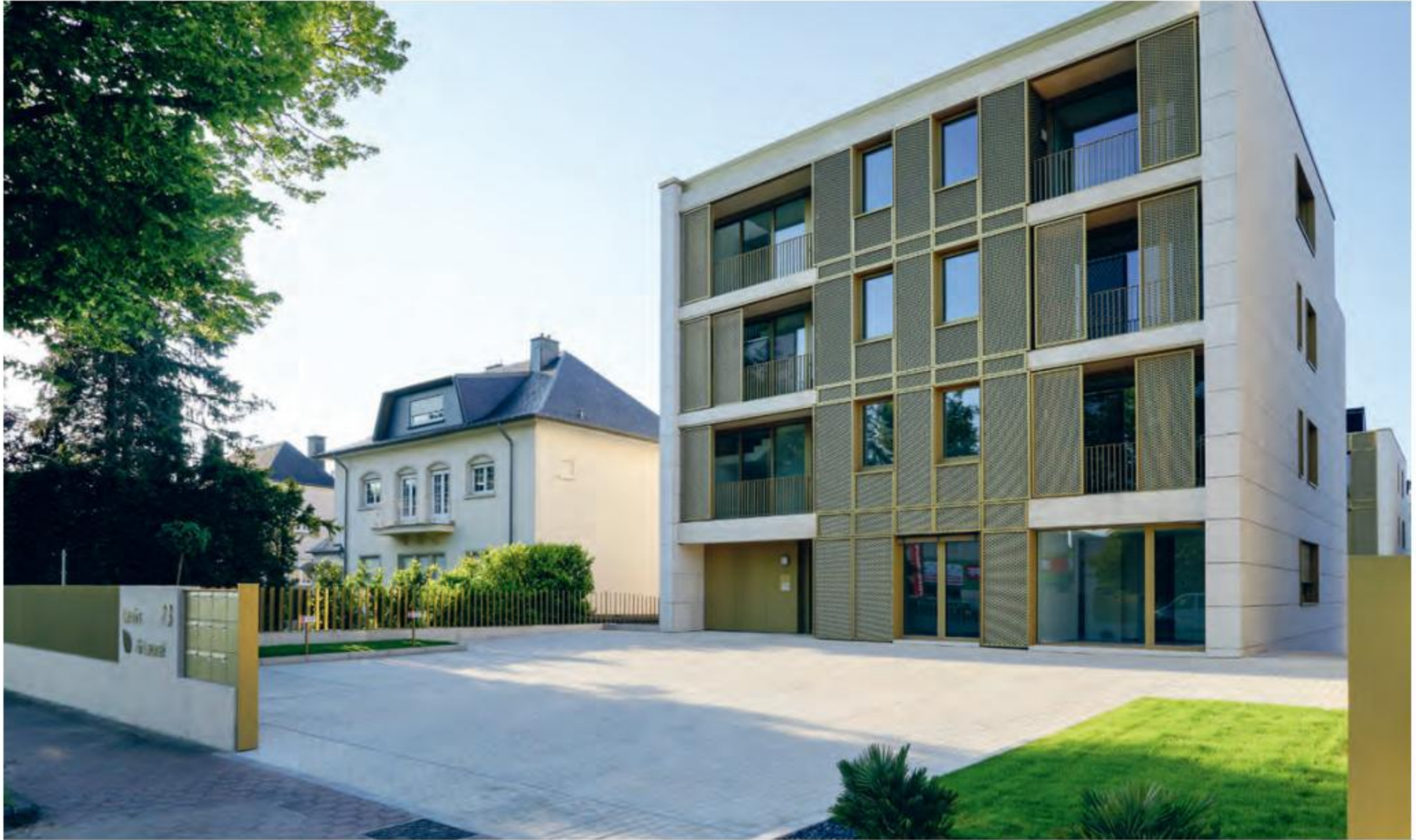
Ce nouvel ensemble comprend 18 appartements et un local commercial.
