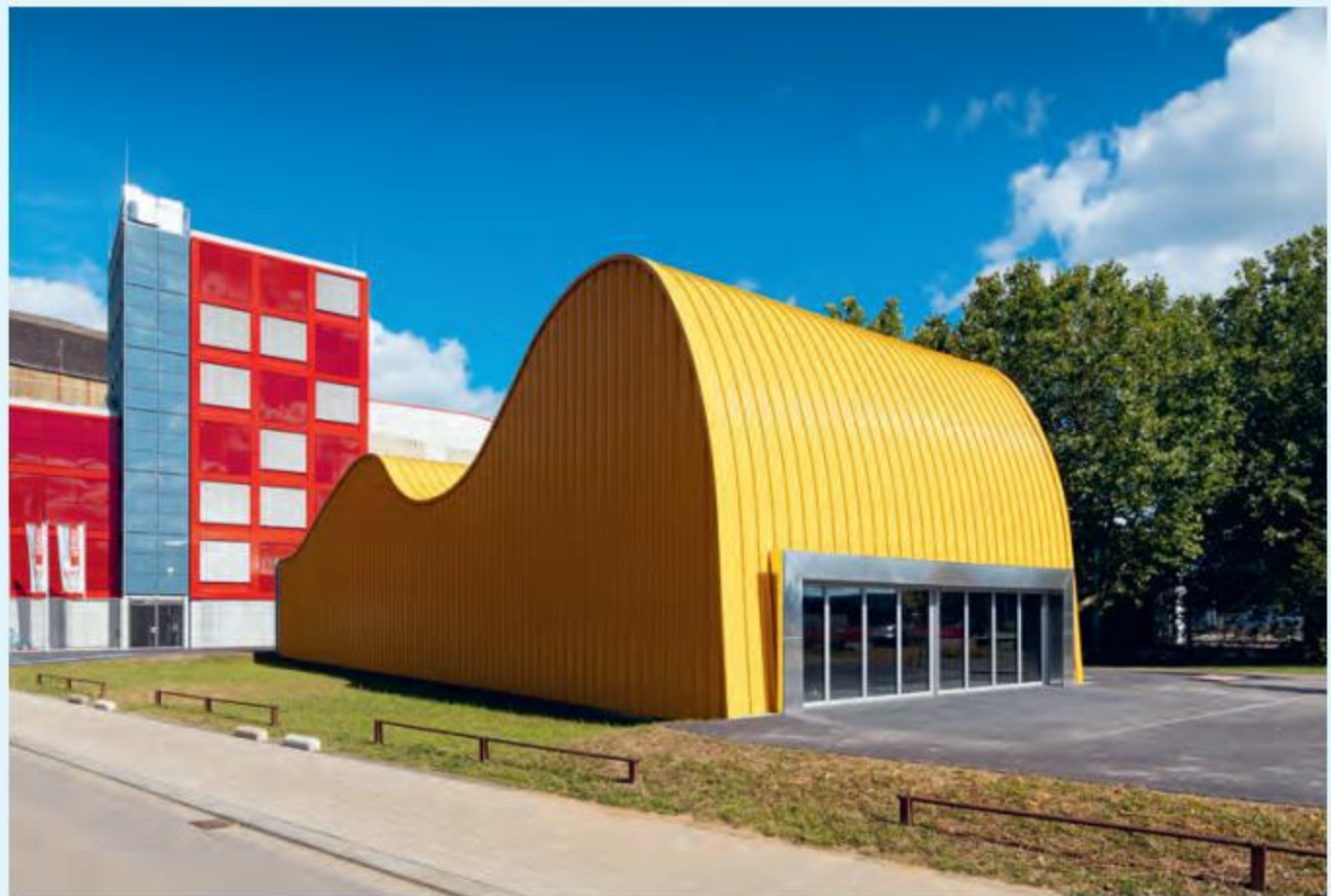
Le bâtiment a été démonté et remonté à moins de deux kilomètres de son emplacement initial.
