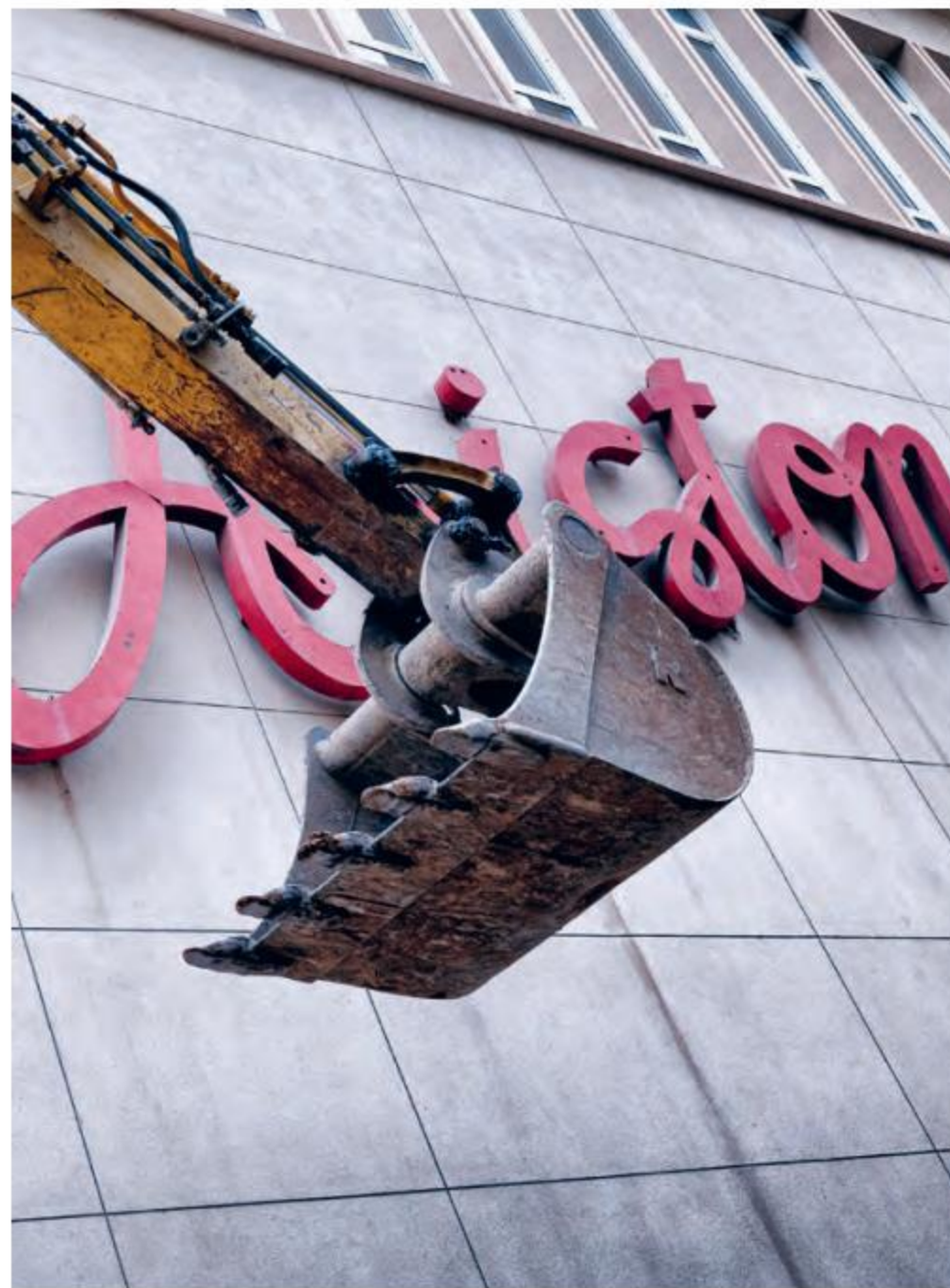
Les travaux entrent désormais dans leur phase finale pour l'ancien Ciné Ariston.
