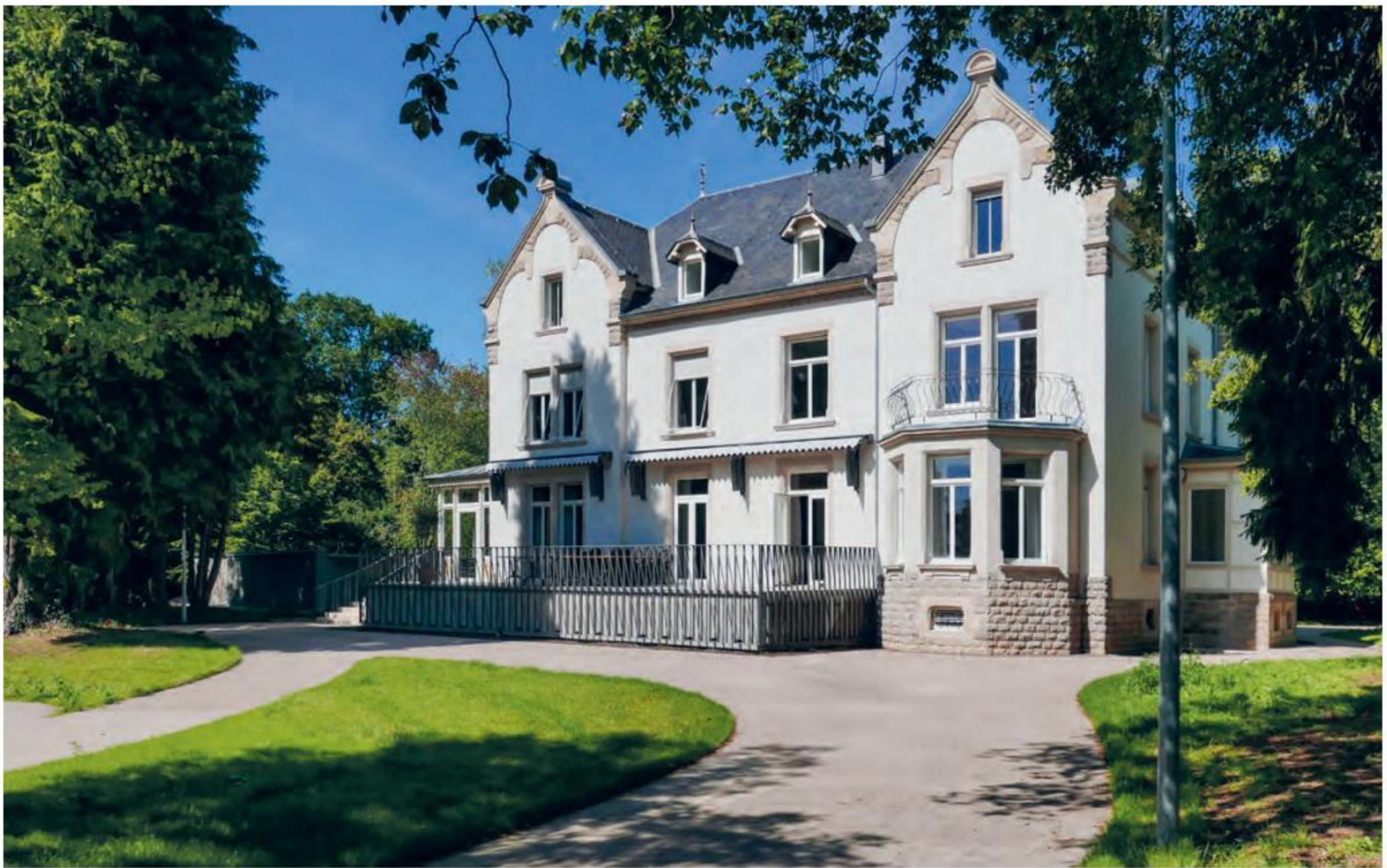
Une nouvelle terrasse a été ajoutée sur la façade sud.
