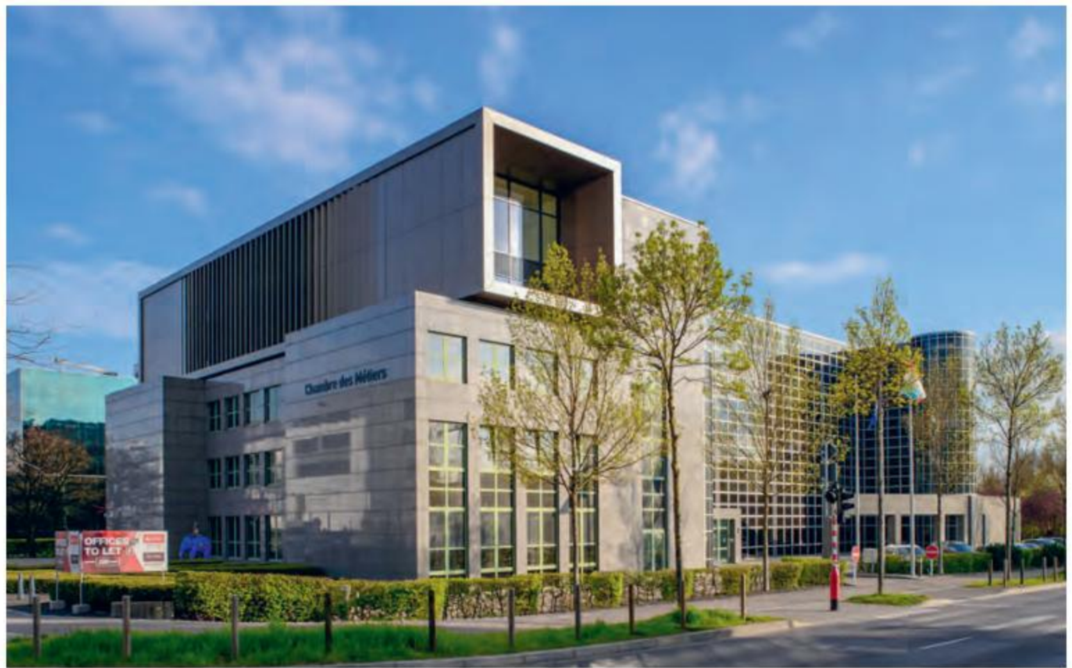
L'une des façades de l'extension est largement ouverte pour faire entrer la lumière naturelle.
