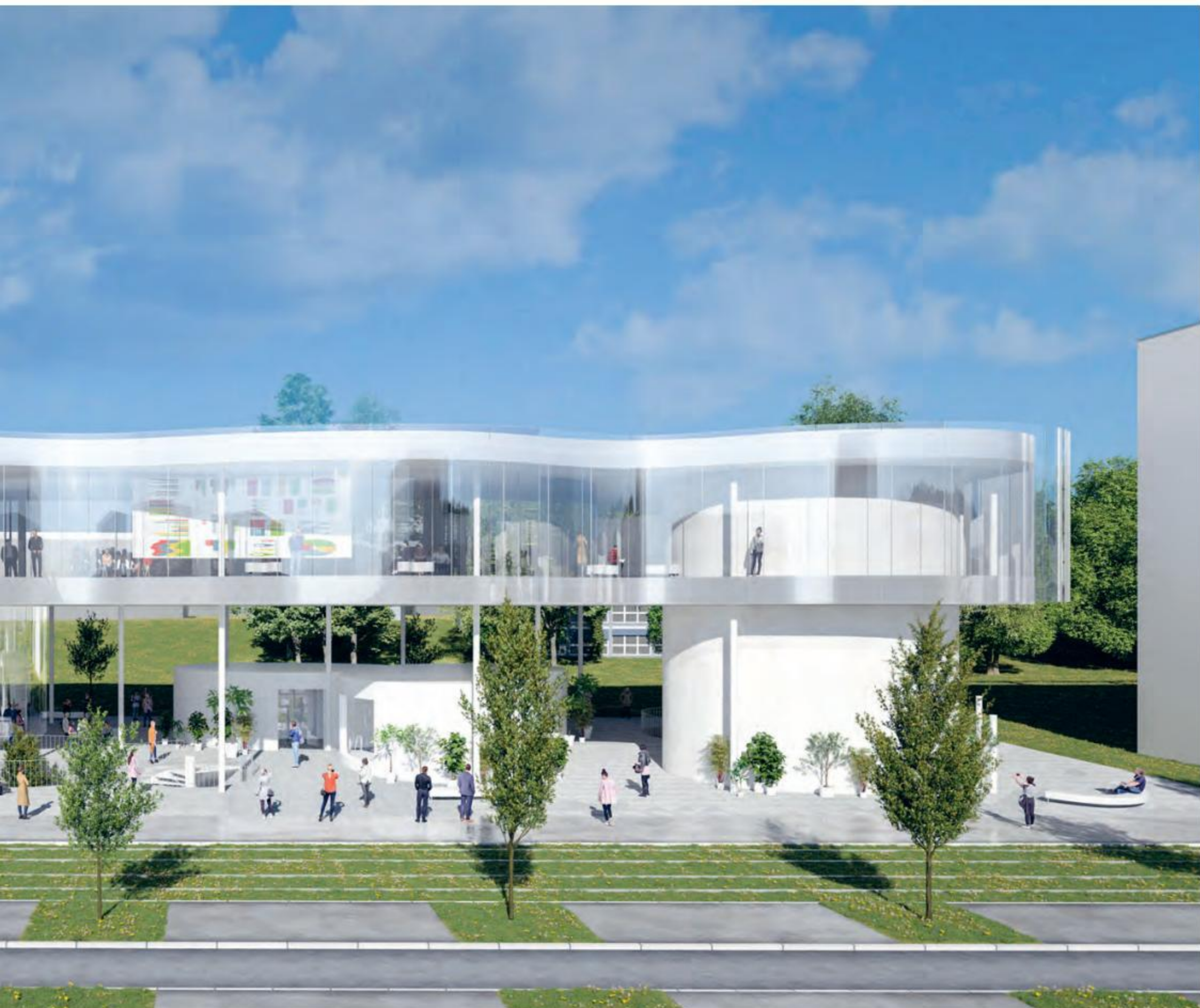
Le futur bâtiment The Cloud présente une façade en verre ondulante.
