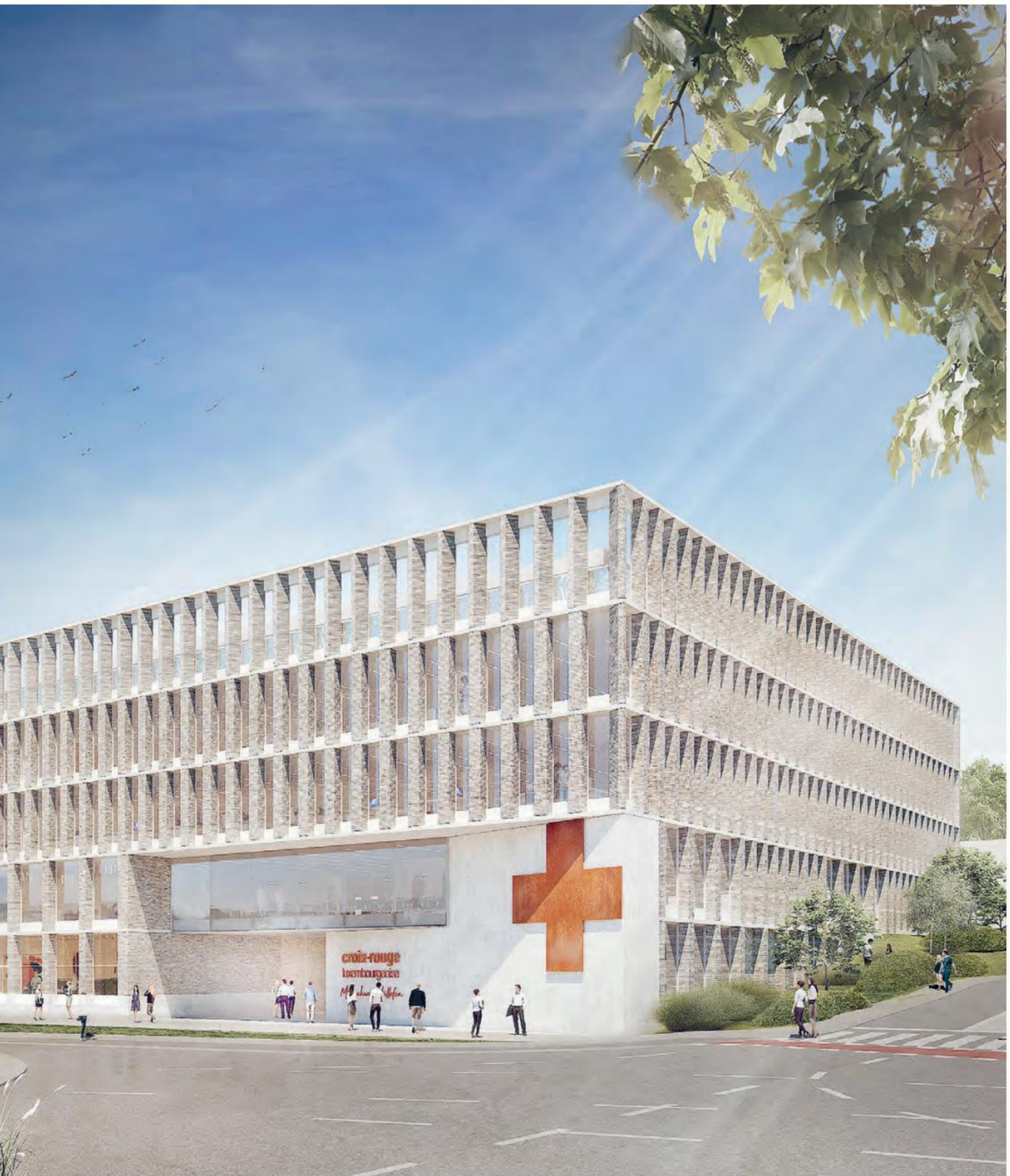
La Maison de la Croix-Rouge sera un bâtiment urbain à l'architecture sobre.
