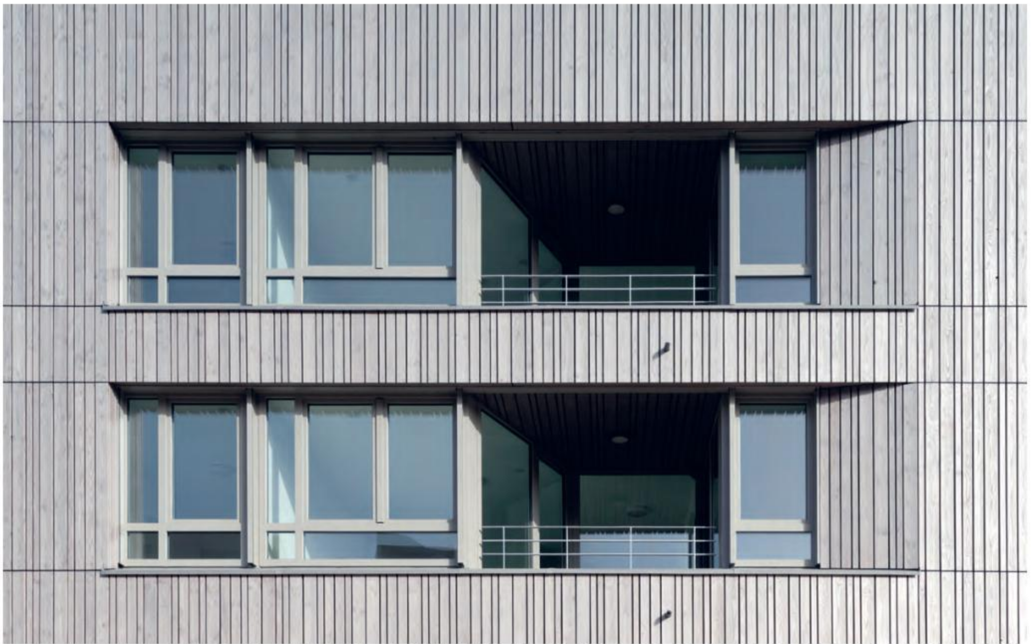
Chaque logement dispose d'une loggia.
