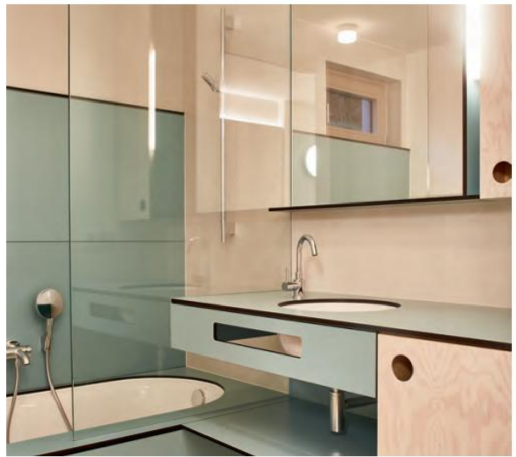
Les salles de bains ont été refaites et aménagées à l'aide de stratifiés compacts colorés.
