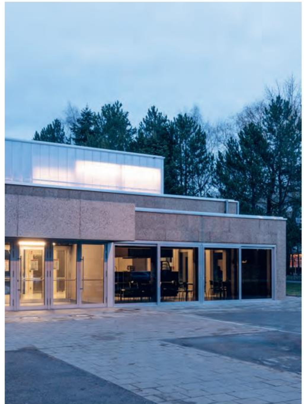
Le bâtiment existant a été conservé et une nouvelle construction légère est placée sur le toit.
