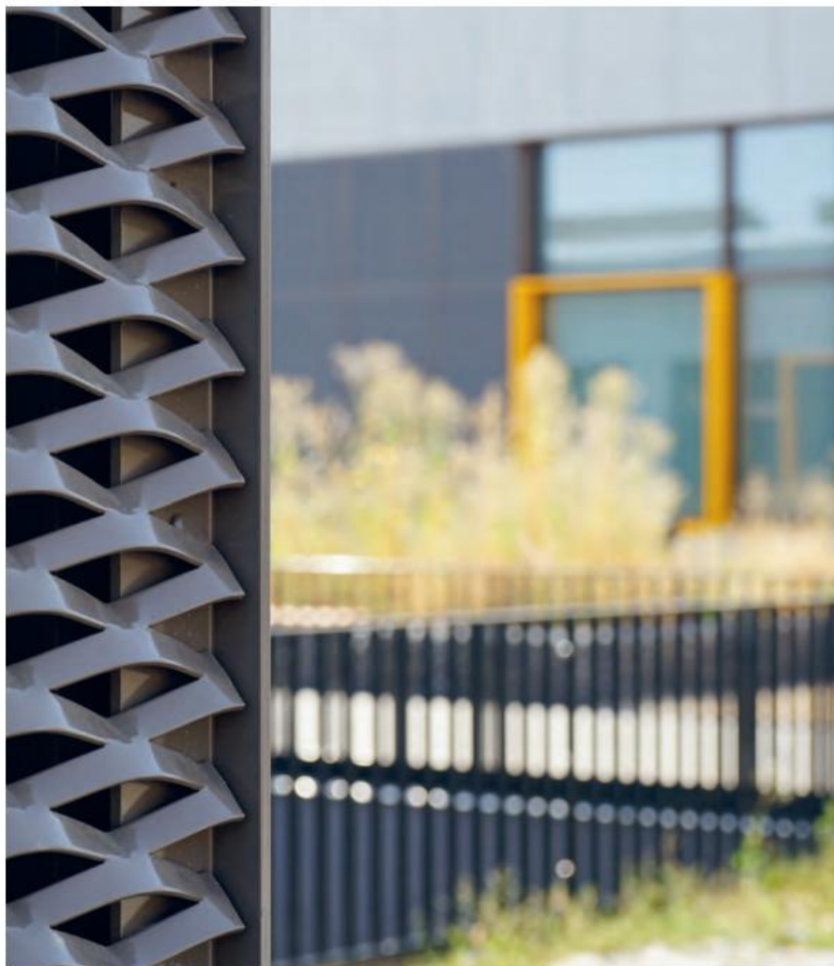
Des panneaux métalliques grillagés servent de protection solaire.
