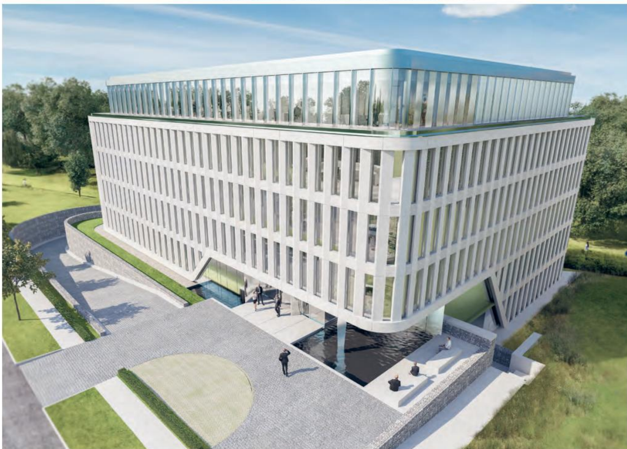
L'entrée de l'immeuble est en retrait, et un plan d'eau accompagne les visiteurs.
