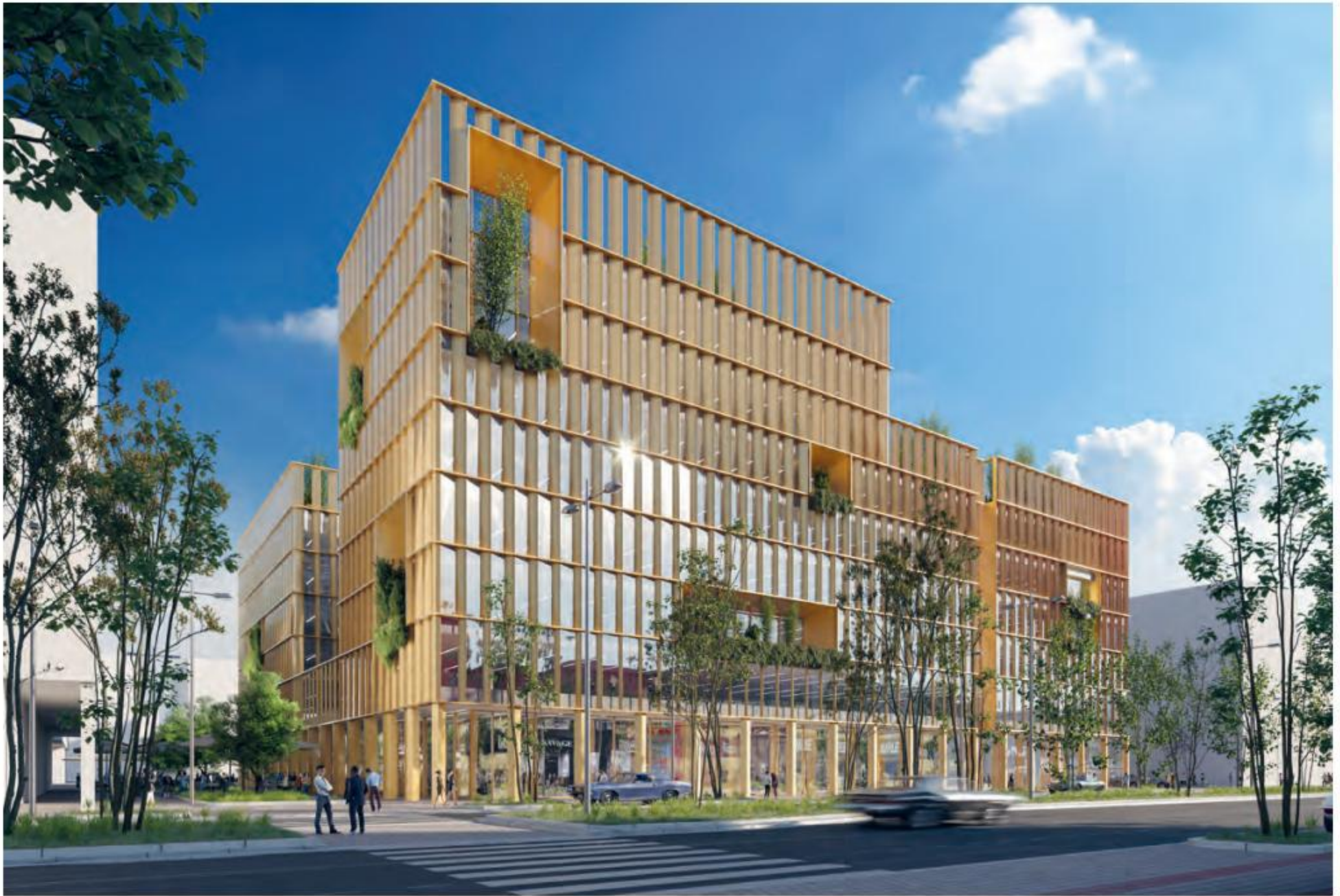
La façade métallique fait référence de manière contemporaine au passé industriel du site.
