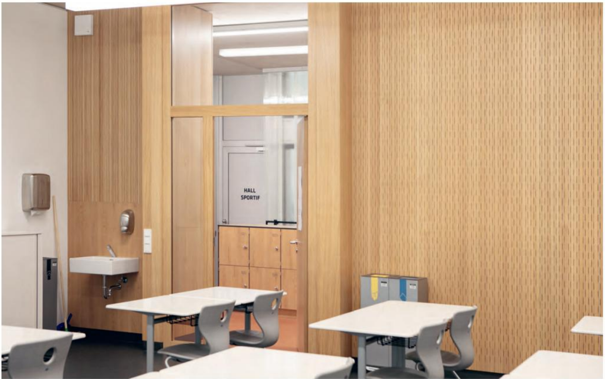
Les salles de classe ont un revêtement mural intérieur en bois pour une meilleure acoustique.
