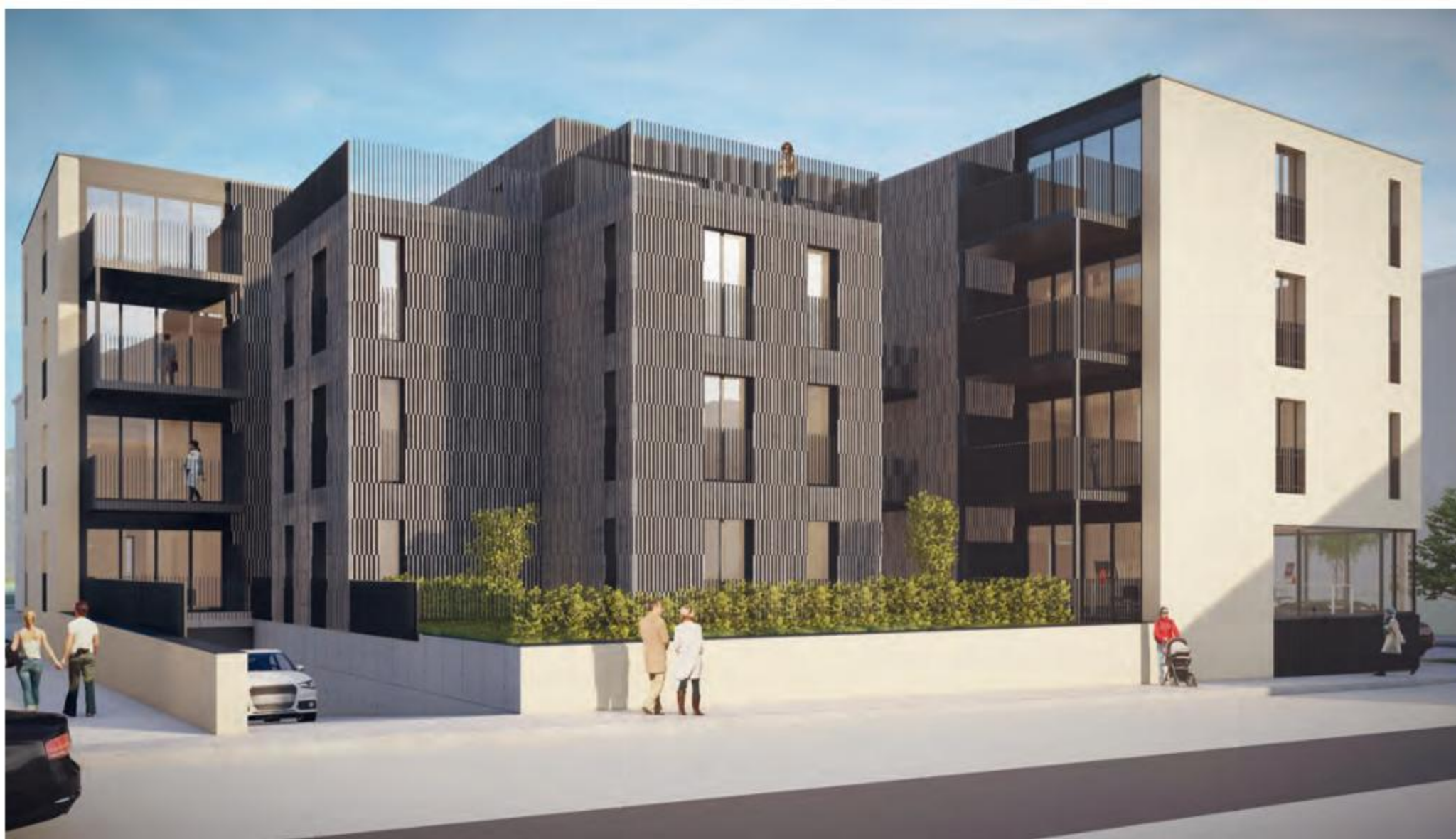
Cette résidence du Fonds du logement est réalisée à l'aide d'un système de dalles alvéolaires en bois.
