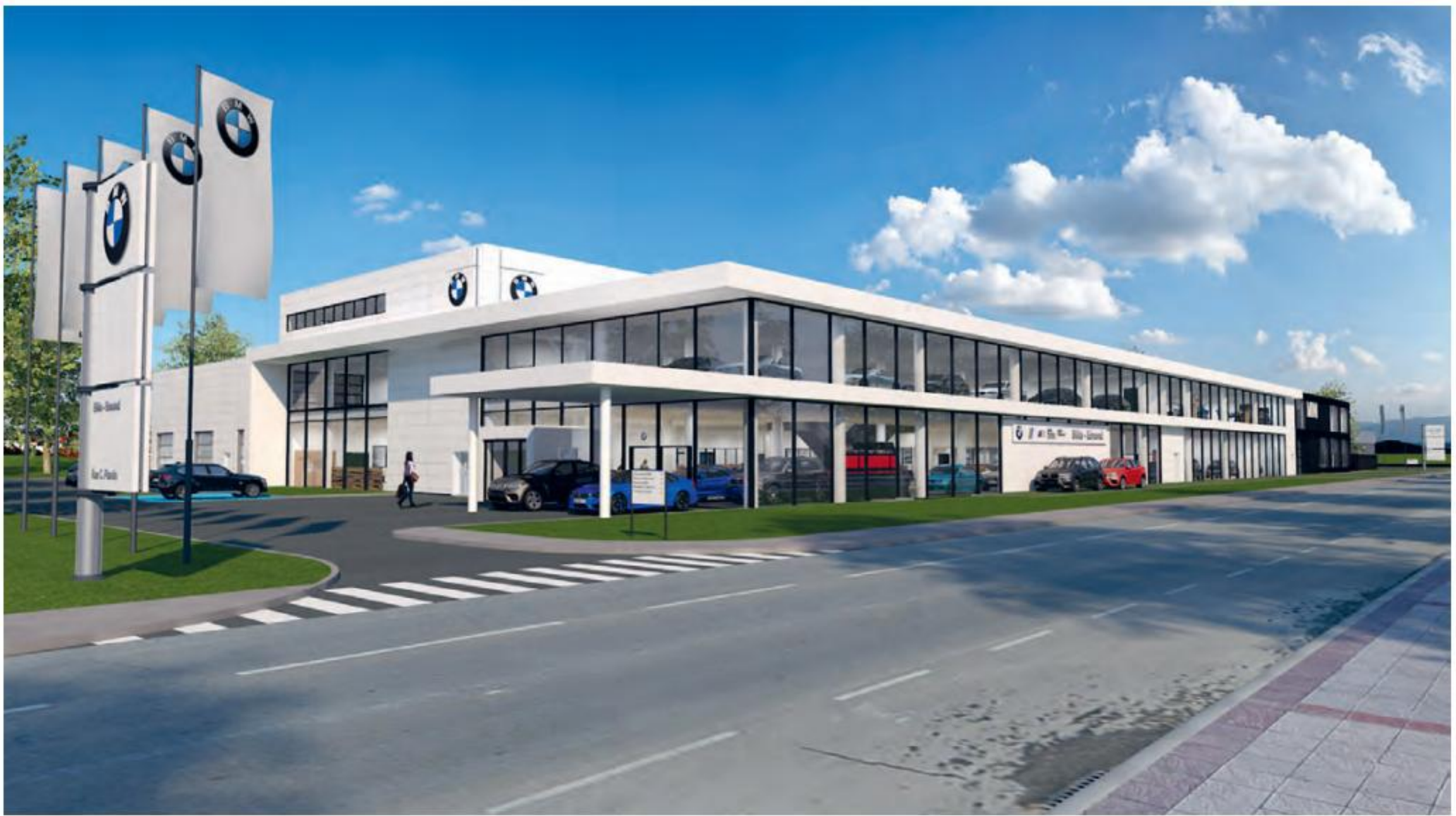
La nouvelle concession BMW est en construction à la Cloche d'Or, à Luxembourg.
