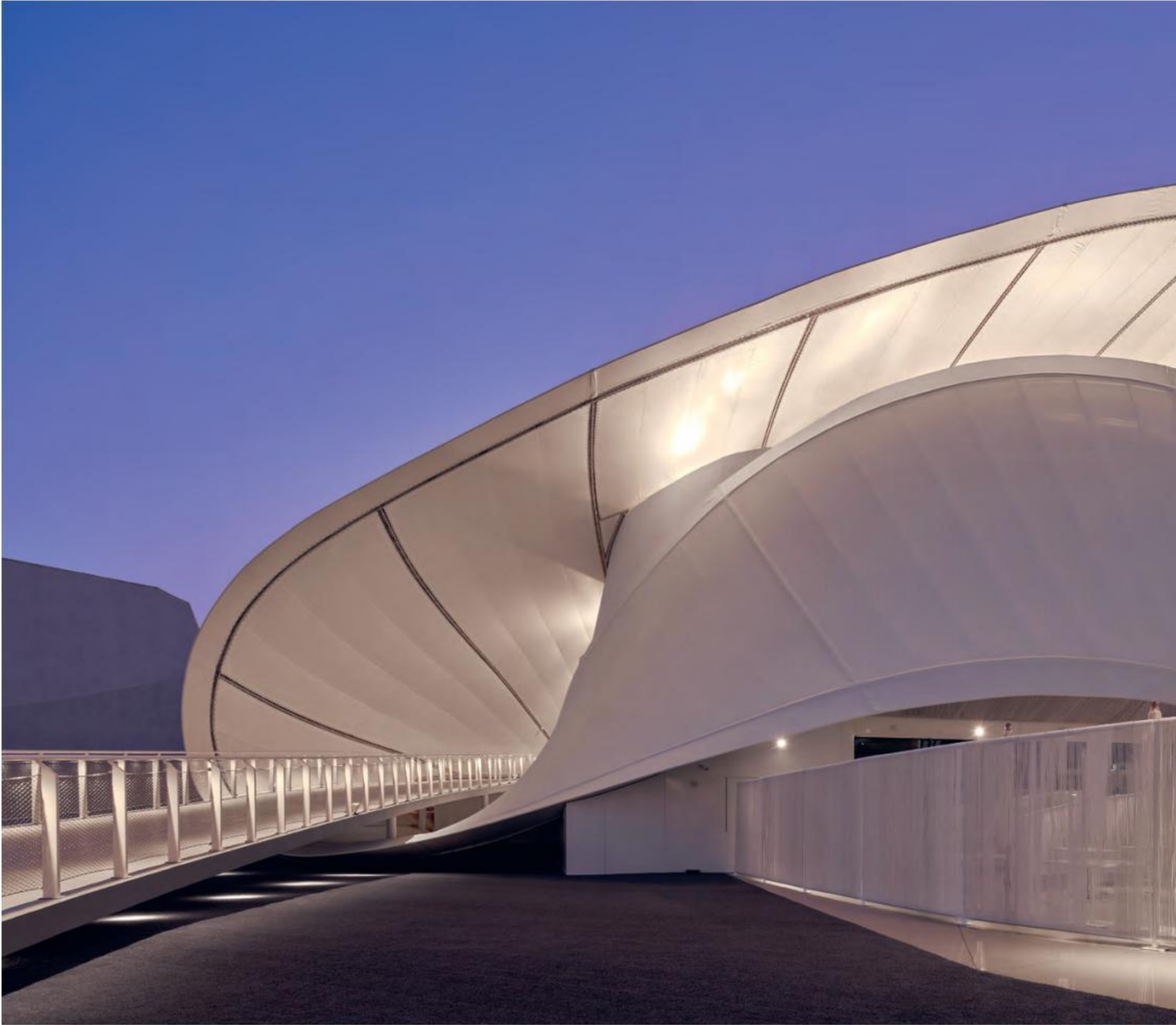
Le pavillon tient sa blancheur d'une membrane en fibre de verre.
