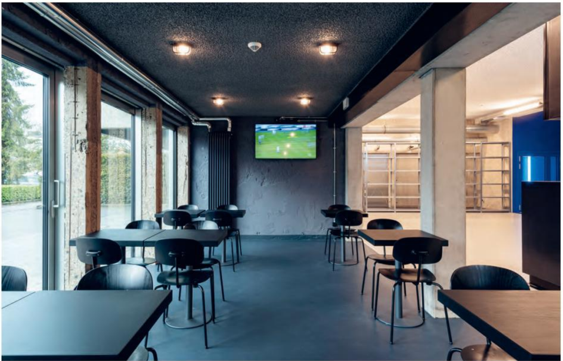
Les techniques sont laissées apparentes et les faux plafonds ont été évités.
