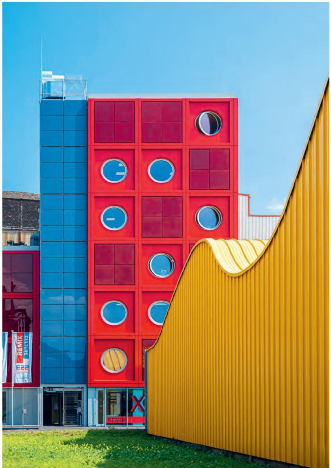
Le bâtiment administratif est composé de modules préfabriqués.
