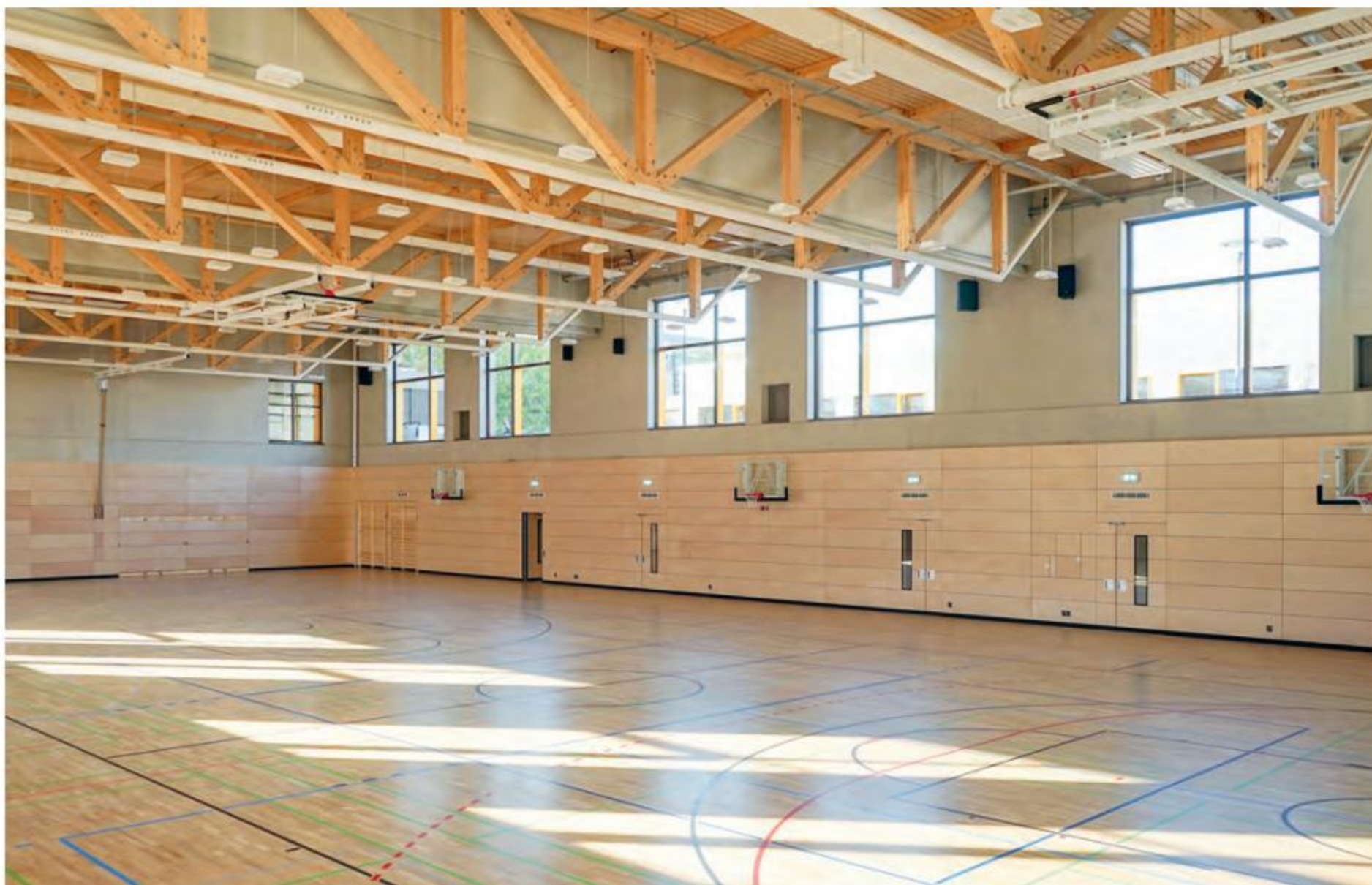
Le hall des sports a une charpente en bois et en métal.
