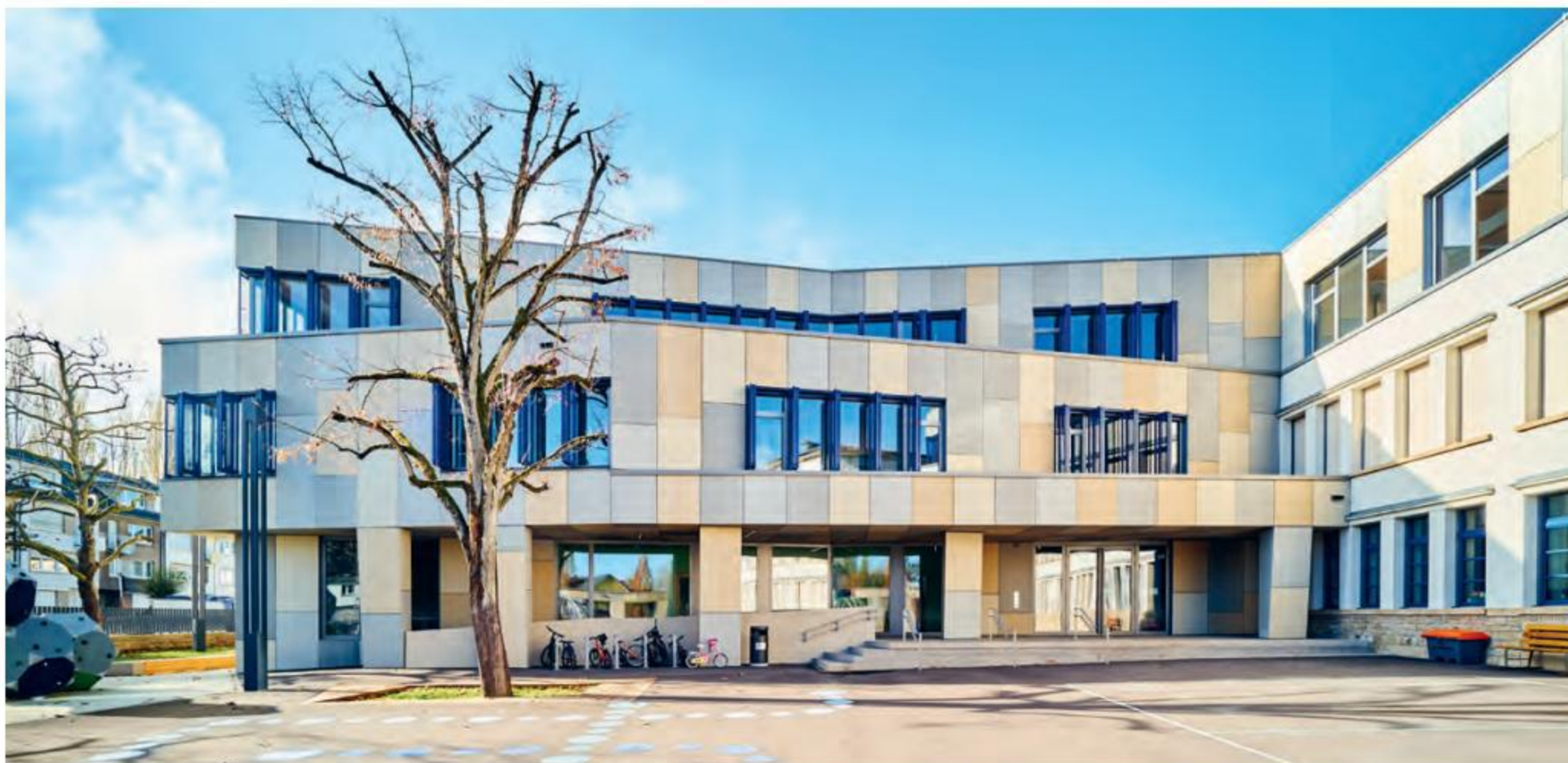
La nouvelle extension présente une façade ventilée avec des panneaux en béton de fibre de verre de teintes beiges et grises.
