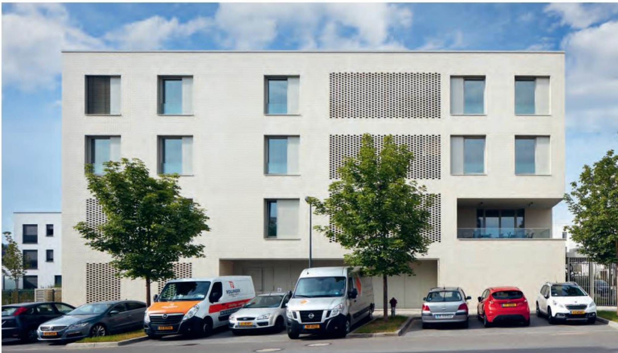
La résidence Séquoia présente une façade en briques claires.
