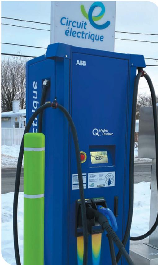
**Étape 1 :** Branchez le pistolet de recharge compatible au véhicule. Le voyant rouge s'allume sur le pistolet CHAdeMO.
