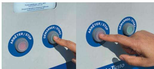
**Étape 3 :** La borne effectue les tests des dispositifs de sécurité avant de permettre la recharge. Lorsque le bouton vert Démarrer clignote, appuyez dessus. La recharge va alors commencer.
