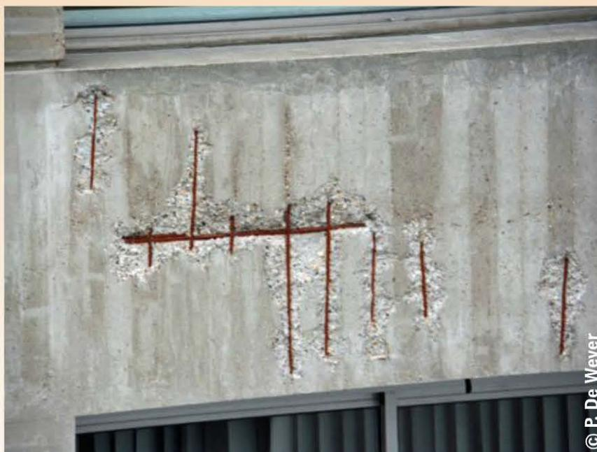
**Fig 21 • Altération d'un béton.**
