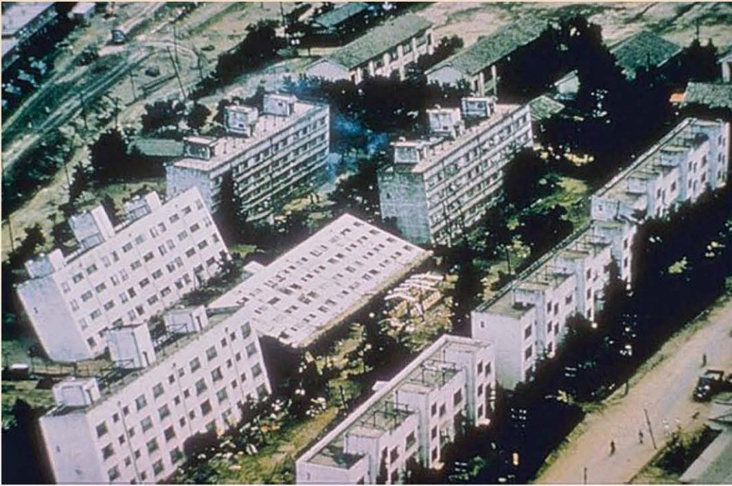
**Fig 70 • Phénomène de liquéfaction des sols sableux lors du séisme de Niigata.** Quand le sol devient mou, il ne soutient plus les bâtiments, qui peuvent se mettre à pencher, se coucher ou se disloquer. Photo tirée de : <http://hommelibre.blog.tdg.ch/archive/2011/04/19/japon-maintenant-le-sol-se-liquefie.html>
