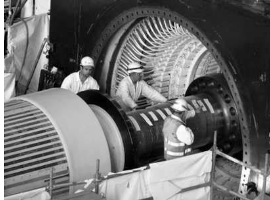
Mise en place du rotor dans un alternateur de centrale nucléaire
