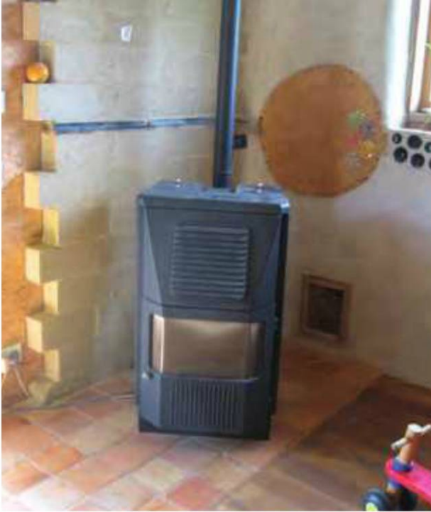
Le poêle est installé devant une masse thermique formée de briques de terre comprimée. (© Bruno Onfray.)
