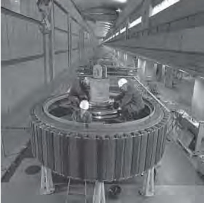
Photo 7.1 EDF. Centrale marémotrice de la Rance
