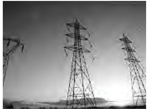
Pylônes double drapeau ou à 2 circuits.
