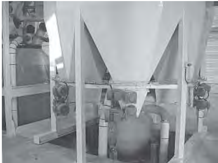
Figure 17.8 Pompage de sortie d'un silo à grains de coopérative agricole.
