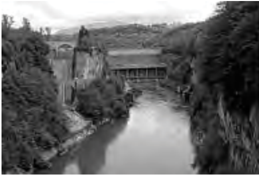
(Barrage de Génissiat, 1948, 420 MW)
