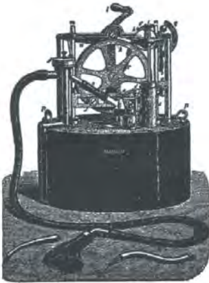
Figure 13.39. Machine de Raphaël Dubois, représentée dans Anesthésie physiologique et ses applications . Chaque godet de la machine de Dubois portait un chiffre en relief, indiquant le nombre de grammes de chloroforme mélangés à 100 litres d'air.
