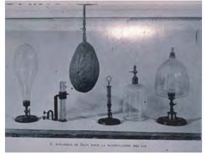
Figure 1.52. Appareils de Humphry Davy pour la manipulation des gaz, parmi lesquels se trouve une vessie à gaz. Planche 3 du catalogue de l'exposition consacrée à Humphry Davy et Michael Faraday, en 1948, au Palais de la Découverte. Un appareil portable coûtait 3 livres et 15 shillings (environ 30,15 F). © Archives de l'Académie des sciences de l'Institut de France.
