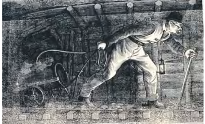
Figure 5.48. © Photographie de Louis Denayrouze, représentant un mineur, tirant son appareil de sauvetage, dans des galeries relativement étroites. En cas d'éboulement, lorsque la galerie était encombrée de pierres et de tas de gravats, ce système ne servait évidemment plus à grand-chose. Prix des Arts Insalubres de la Fondation Montyon, 1875. © Archives de l'Académie des sciences de l'Institut de France.
