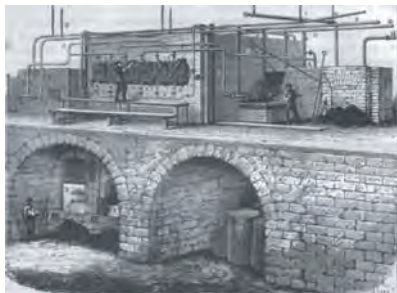
Figure 8.11. Appareil de Tessié du Motay pour la préparation économique du gaz oxygène. Dans Louis Figuier, Les Merveilles de la Science , Paris, 1868, t. 4.
